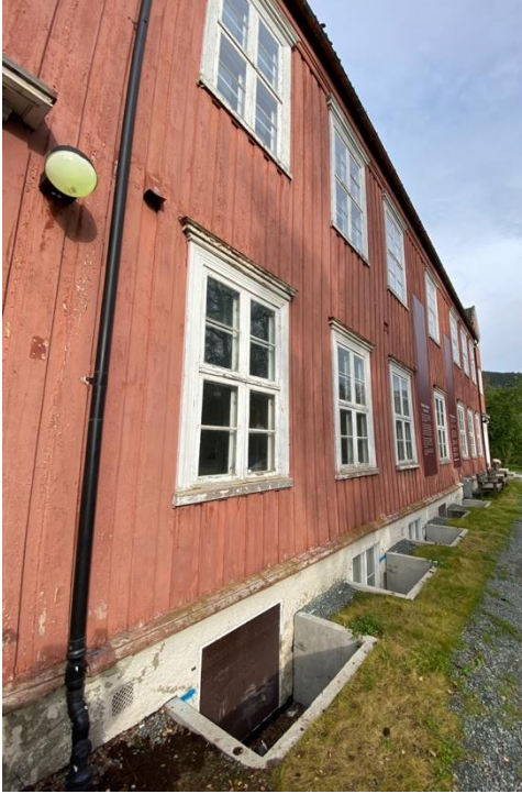
Lysgraver foran kjellervinduer På sørfasade
