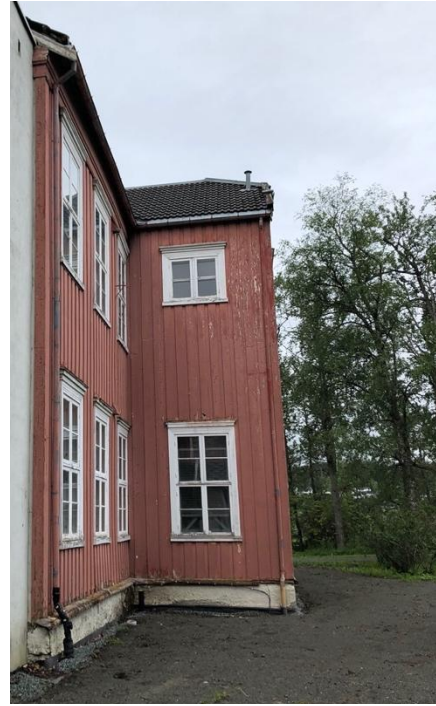
Taknedløp på nordfasaden
