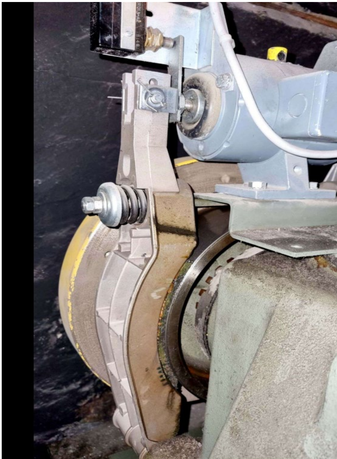
Figur 17 Detalj maskin, brems
