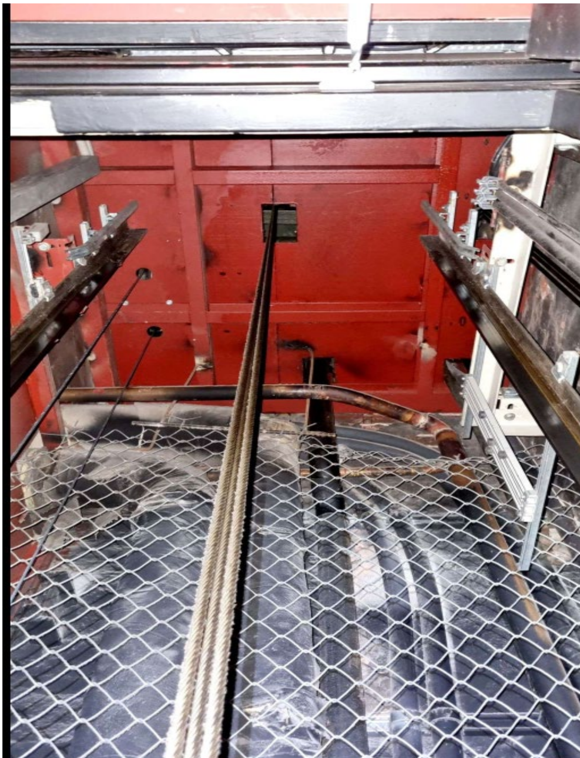
Figur 14 Sjakt topp – maskinrom underside, stål topp
