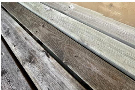
Bilde B9: Terrasse ved pauserom med impregnert trevirke
