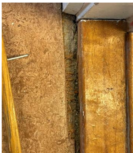
Bilde B4: Prøve nr P04 Rødt linoleumsbelegg i kontordel
