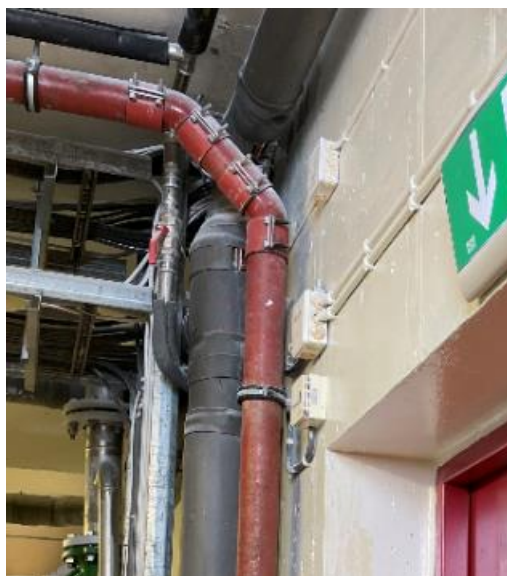
Bilde B8: Sort cellegummi med innhold av brommerte flammehemmere
