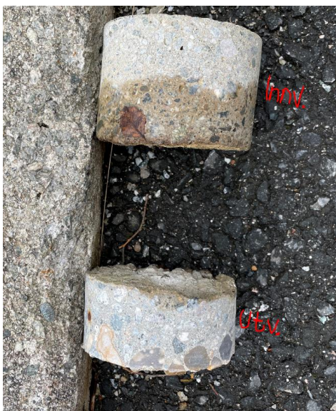
Bilde B7: Prøve nr P08 og P09 Betongelement innvendig- og utvendigdel
