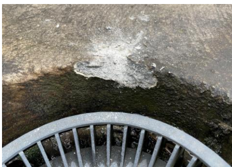
Bilde B1: Prøve nr P01: Betongtak kalksilo
