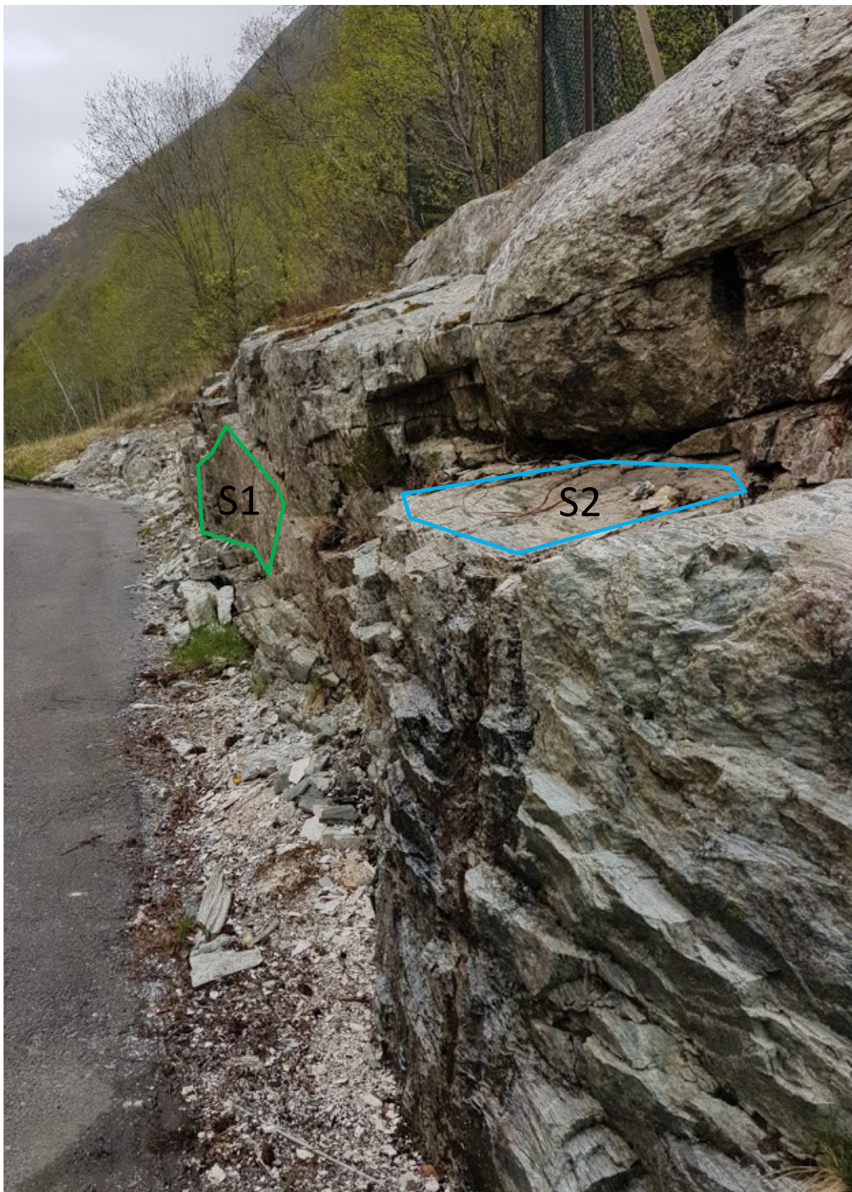
Figur 3: Bilde av bergskjæring som ble brukt til kartlegging av strukturgeologi. Grønn markering illustrerer sprekkesett S1. Blå markering illustrerer sprekkesett S2.
