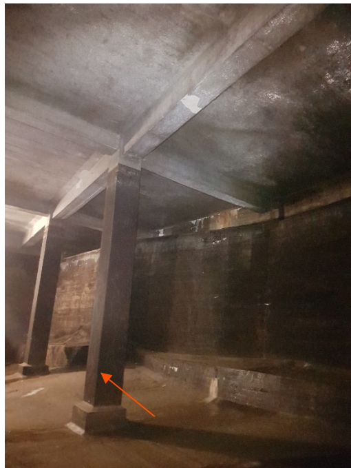
Bilde B4: Oversiktsbilde søyler og tak. Tak og søyler ble oppført samtidig. Rød pil viser omtrentlig prøvepunkt (P02)
