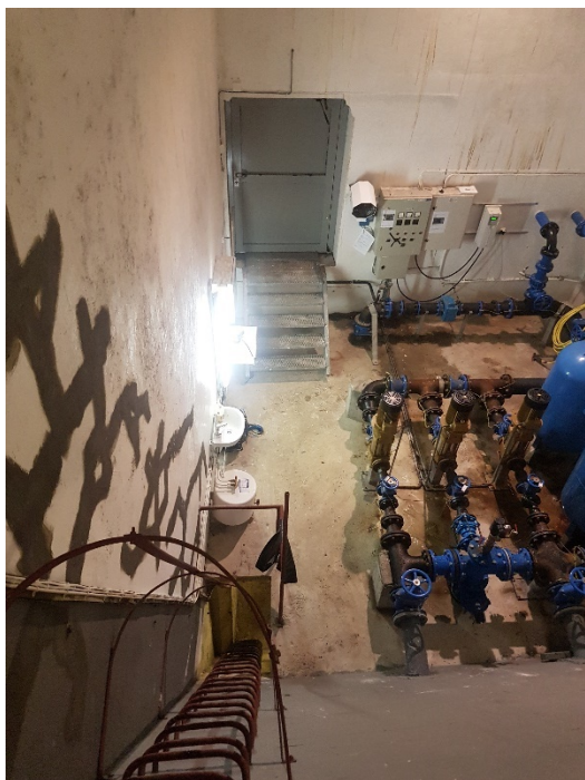
Bilde B13: Pumperom (skal ikke rives)
