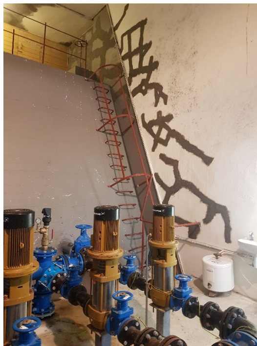
Bilde B14: Pumperom (skal ikke rives)
