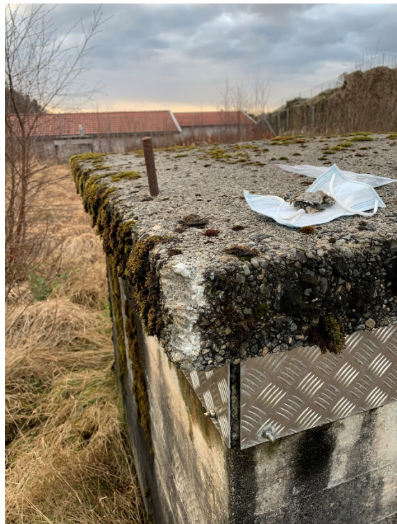
Bilde B10: P07 – Tak ventilasjonstårn
