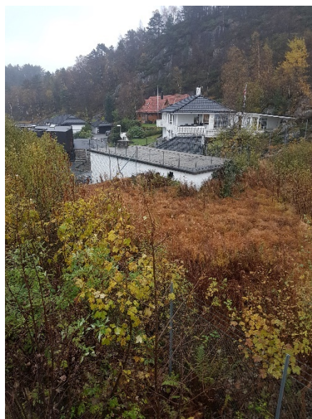
Bilde B12: Overbygg ventilhus med pumperom (skal ikke rives)
