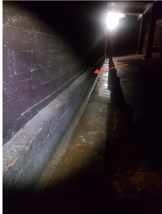
Bilde B2: Oversiktsbilde langvegg. Pil viser omtrentlig prøvepunkt (P01).
