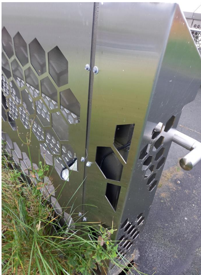
Foto fra eksisterende GANGBRU VEST. Håndløper er ikke med på GANGBRU ØST.
