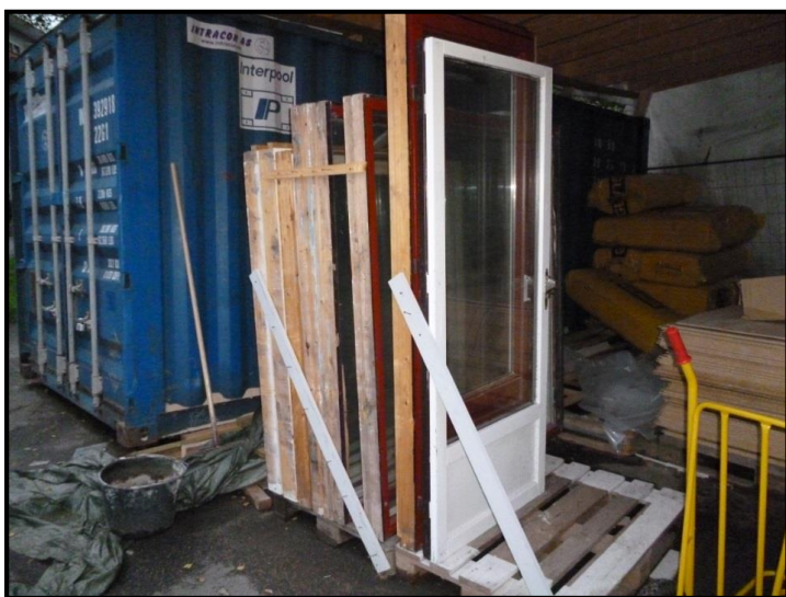
Figur 1: Slik kan vinduer og balkongdører klargjøres for transport.
