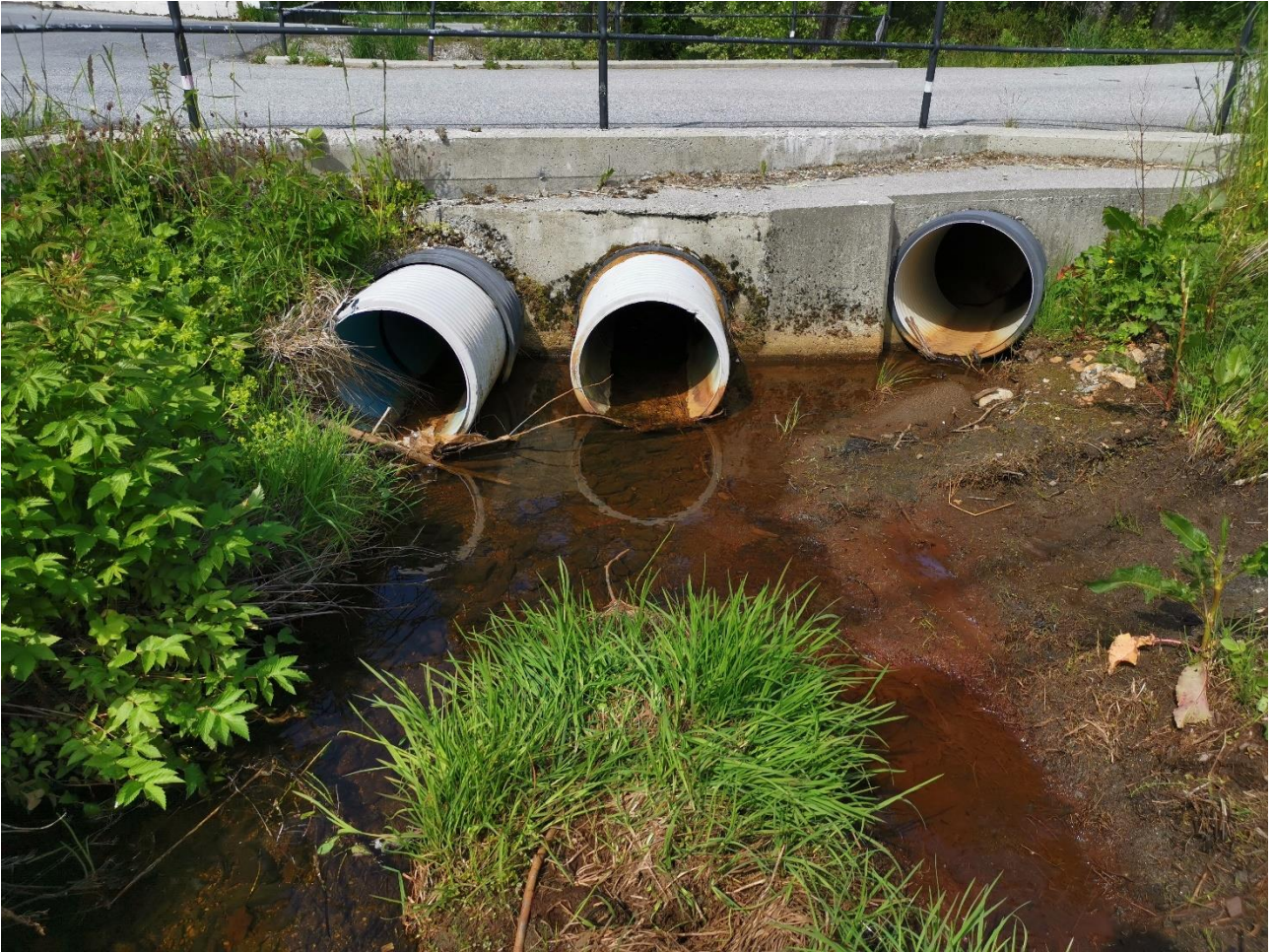
Figur 6. Bekken sett i nedstrøms retning mot kulverten i Vasstrandvegen. Fra høyre i bildet kommer en liten bekk fra myrområdet. Hovedbekken kommer inn fra venstre i bildet.
