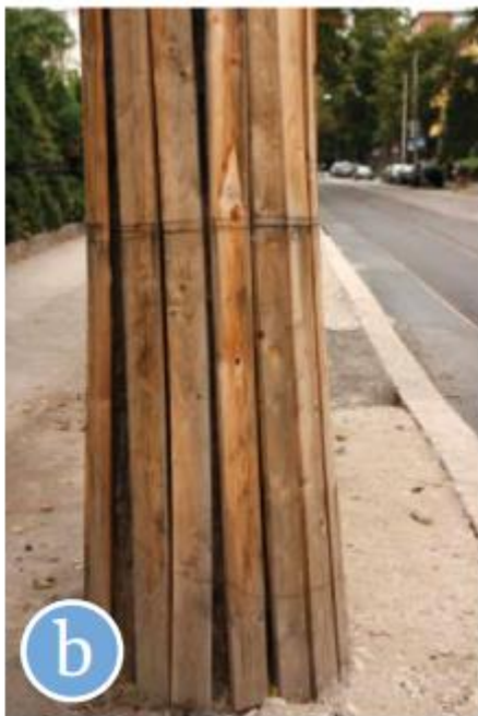
B) Middels beskyttelse - Stammebeskyttelse med planker og drenerør gjør treet først og fremst mer synlig, men gir også noe beskyttelse mot lettere mekaniske skader i barken. Rothalsen og rotplaten er fremdeles ubeskyttet. (foto. Andreas Løvold/bymiljøetaten)
