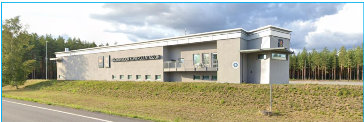
Figur 16: Magnormoen kontrollstasjon. Hentet fra google street view.
