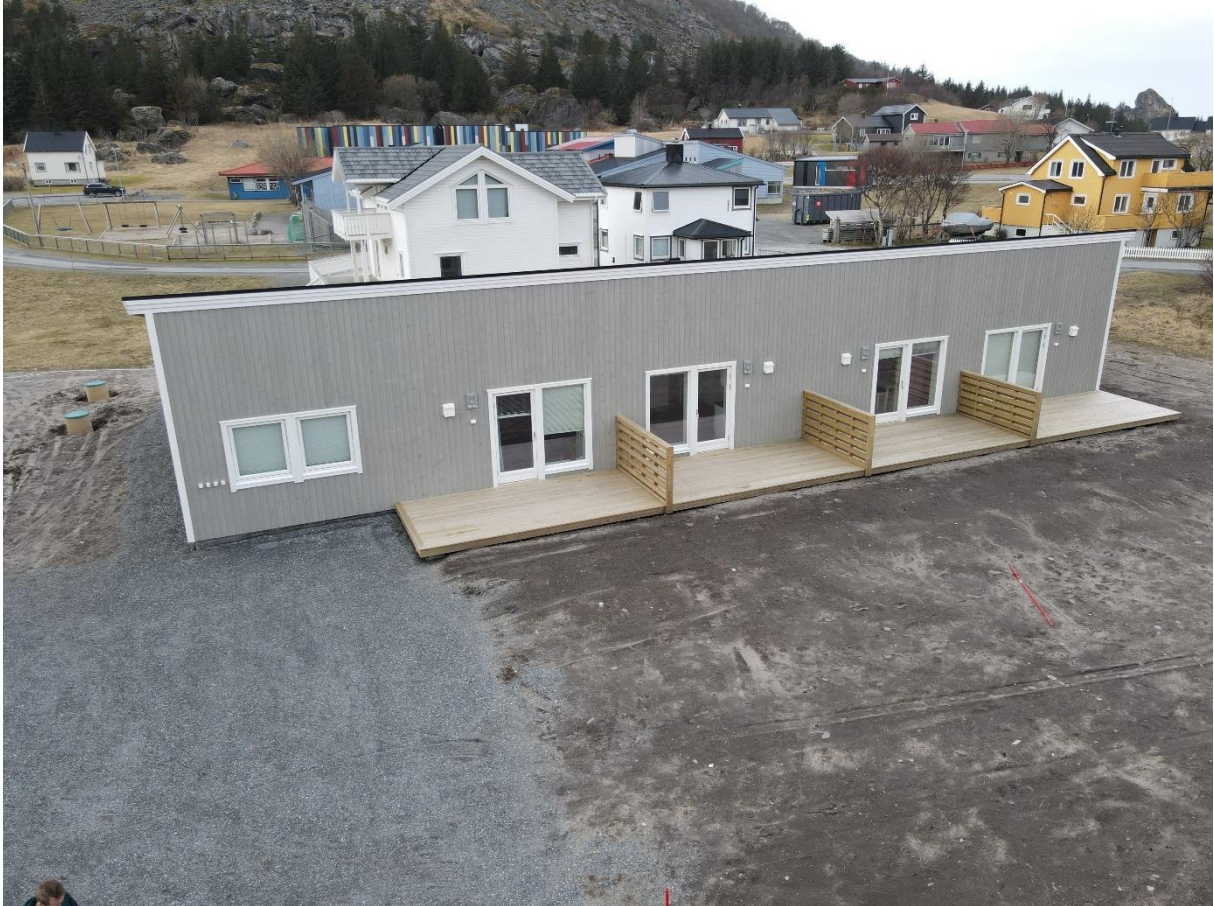
Figur 1 Bygget som skal tilbygges, tilbygg skal være til høyre på bildet
