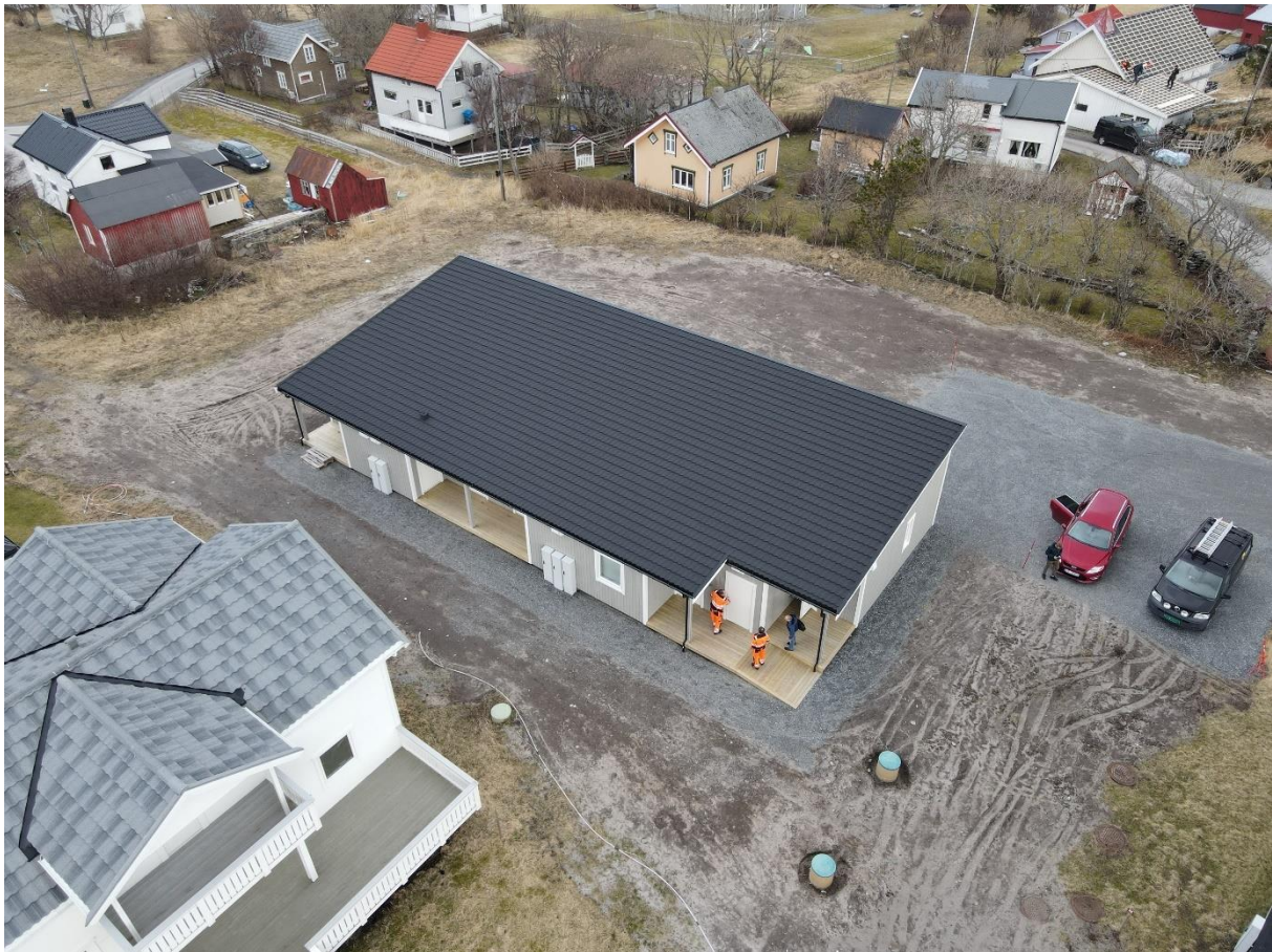
Figur 3 Bygget som skal tilbygges.
