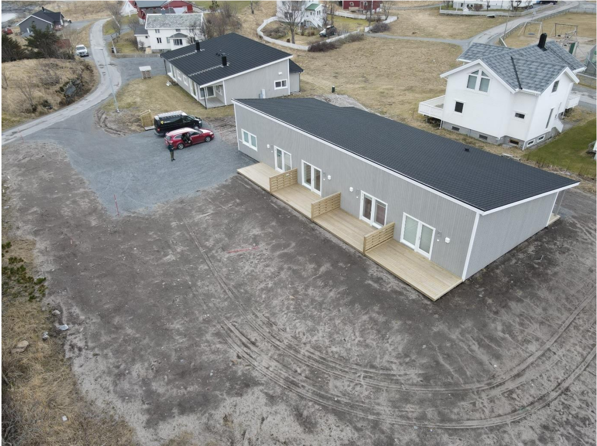
Figur 2 Bygget som skal tilbygges.
