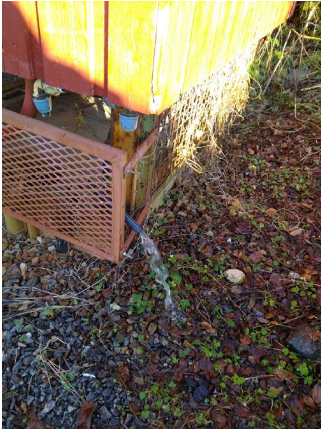
Figur 1. Sigevannprøven er tatt ut fra en stikkledning etter sigevannspumpene. Prøven blir tatt ut som en stikkprøve.
