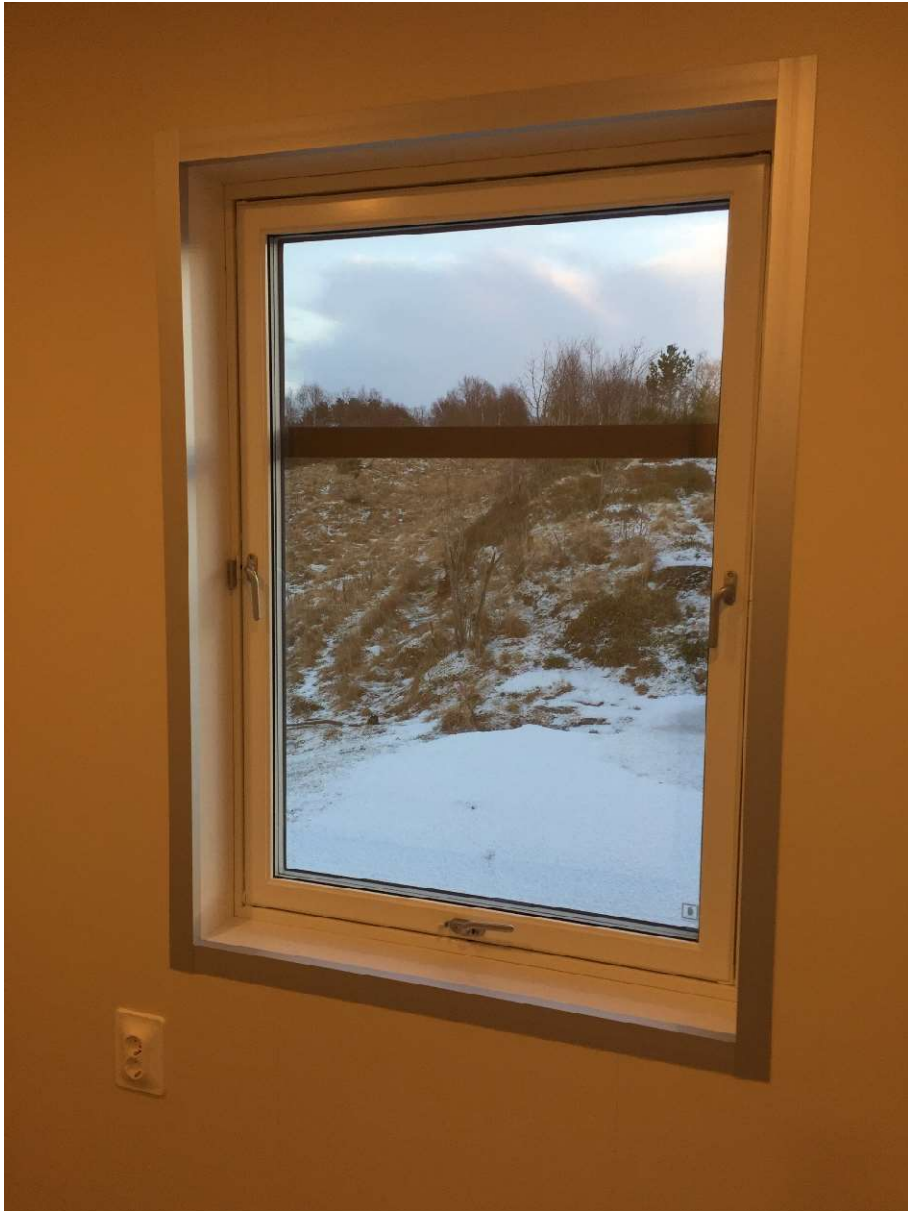
Vindusomramming, foringer av baderomsplater.
