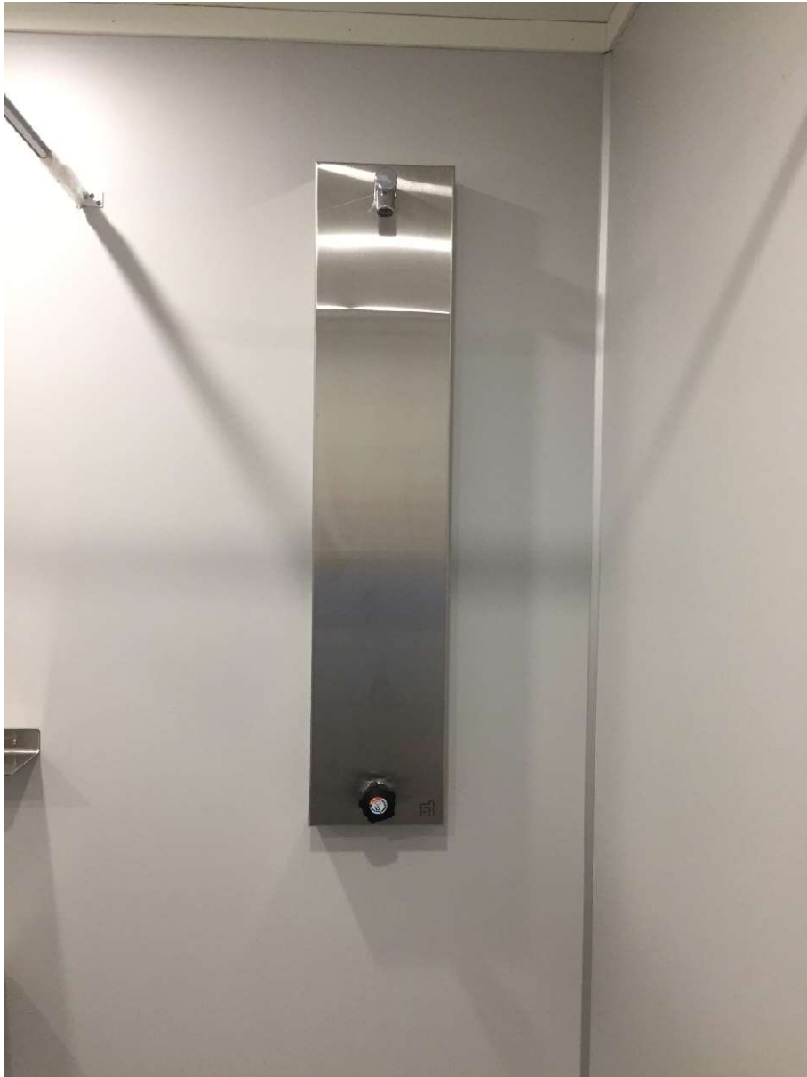
Baderom – Dusj («vandalsikker»).
