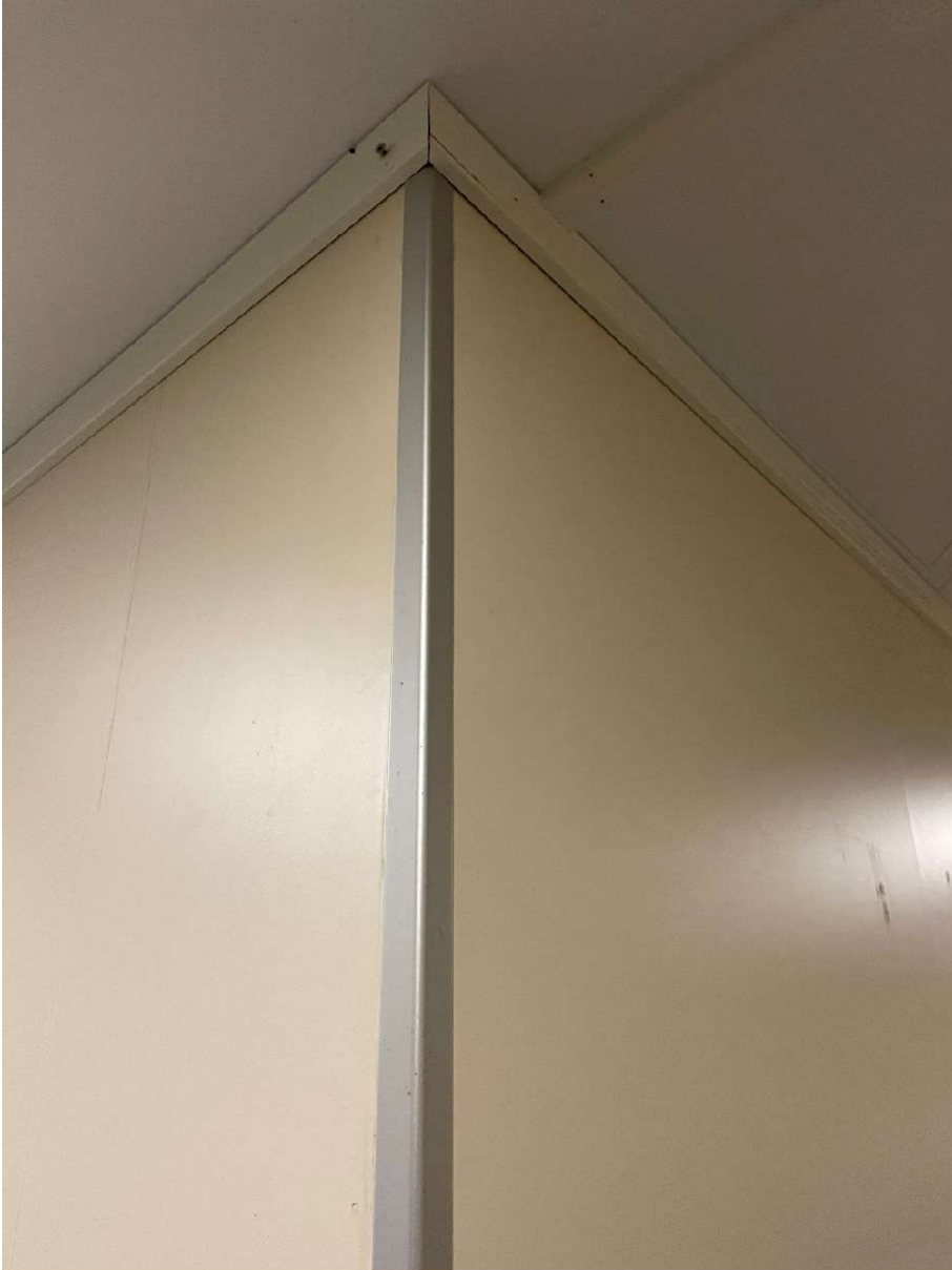
Forsterking av utvendige hjørner.
