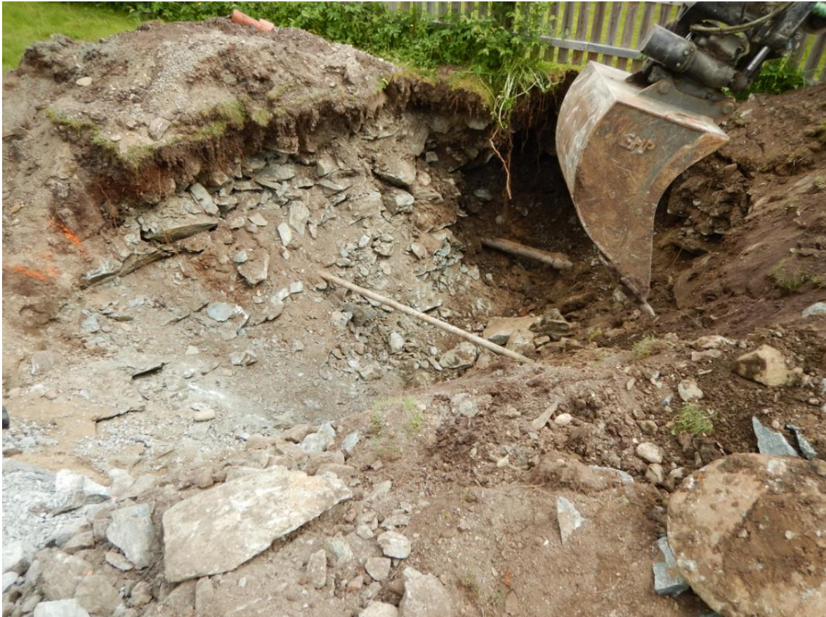
Figur 4-5 Gravearbeider i Øystein Langsets veg 1c. Bildet viser både fyllmasser og (muligens?) oppsprukket berg. Bilde tatt 15.06.2018.
