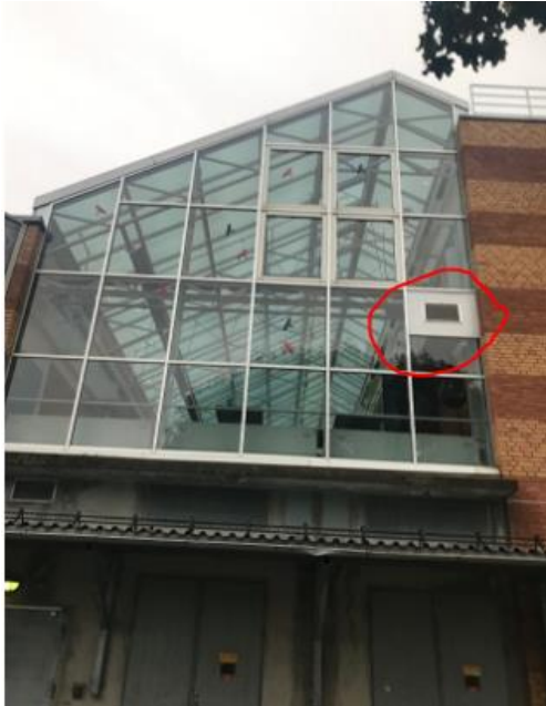
Figur 2.3.3-1 Ragata. Rød ring viser lufteluke.
