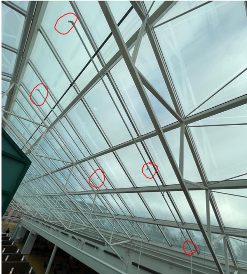
Figur 2.6.3-5. Ragata. Rød ring viser sprinkelhoder
