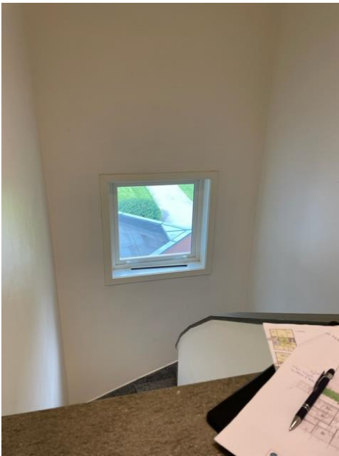
Åpningsbart vindu i bitrapperommet
