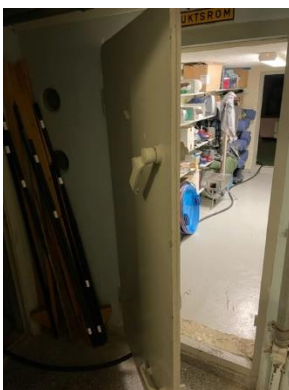
Dør trapperom – tilfluktsrom/lager i kjeller
