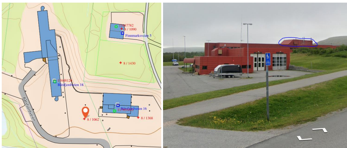
Figur 1: Venstre – utklipp fra www.seeiendom.no . Tiltaket tar sted i underetasjen i byggverket til venstre. Høyre – utklipp fra www.instantstreetview.com . Blå markering viser plan 03 med teknisk rom.
