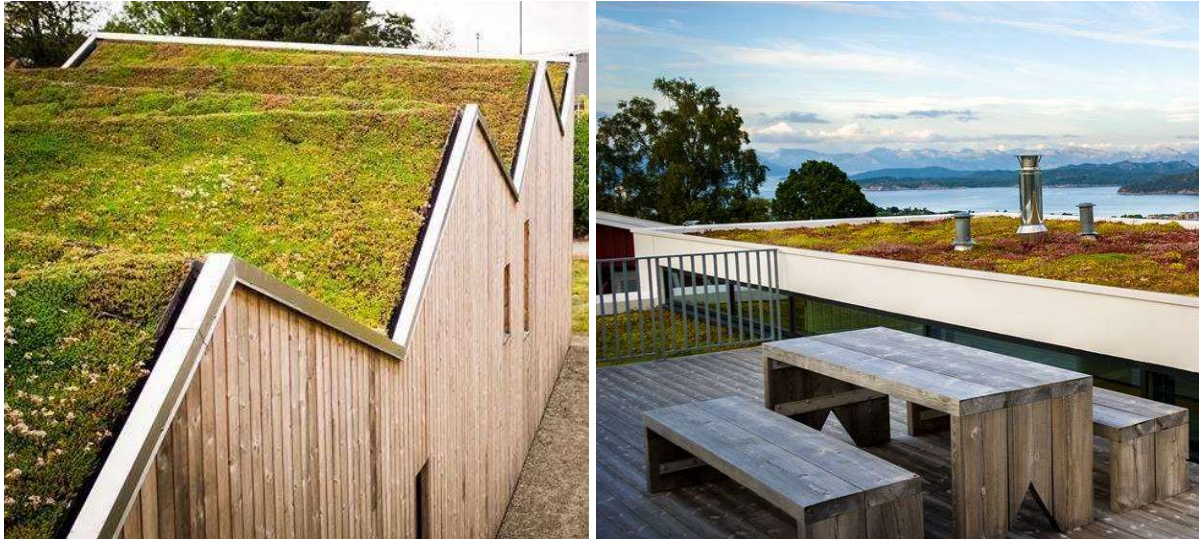
Figur 2. Bildene illustrerer sedum-tak med ulike vinkler og er hentet fra nettet for inspirasjon
