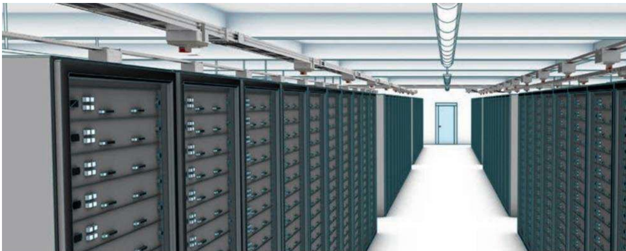
Figur 4 Skinneløsning for strømtilførsel
