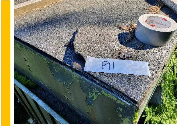
Figur 7-5 Takpapp og lim. Inneholder ikke asbest.
