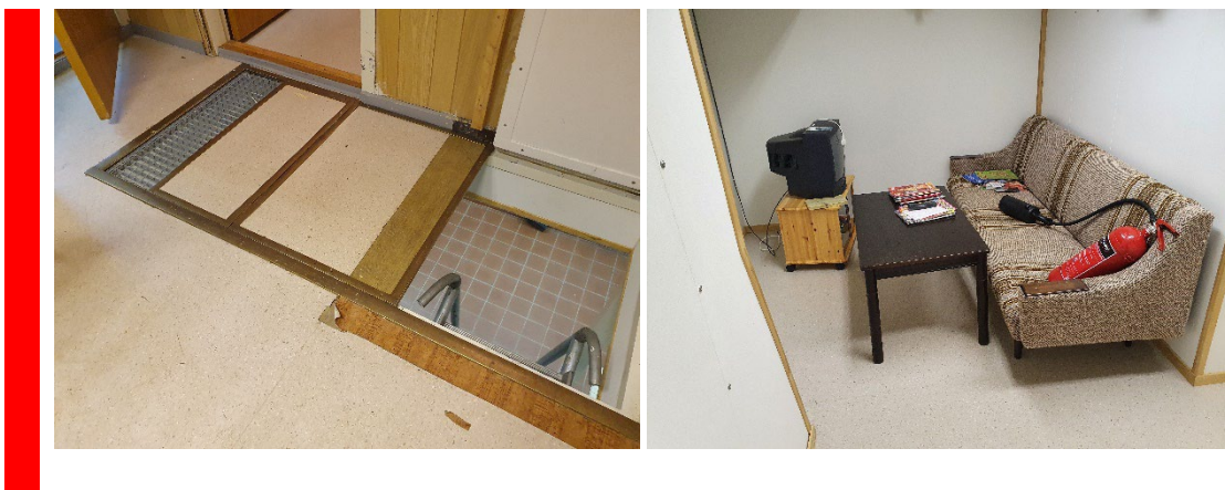
Figur 7-7 Vinylbelegget håndteres som farlig avfall med ftalater.
