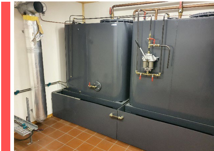
Figur 7-9. I kjelleren ble det registrert 2 oljetanker.
