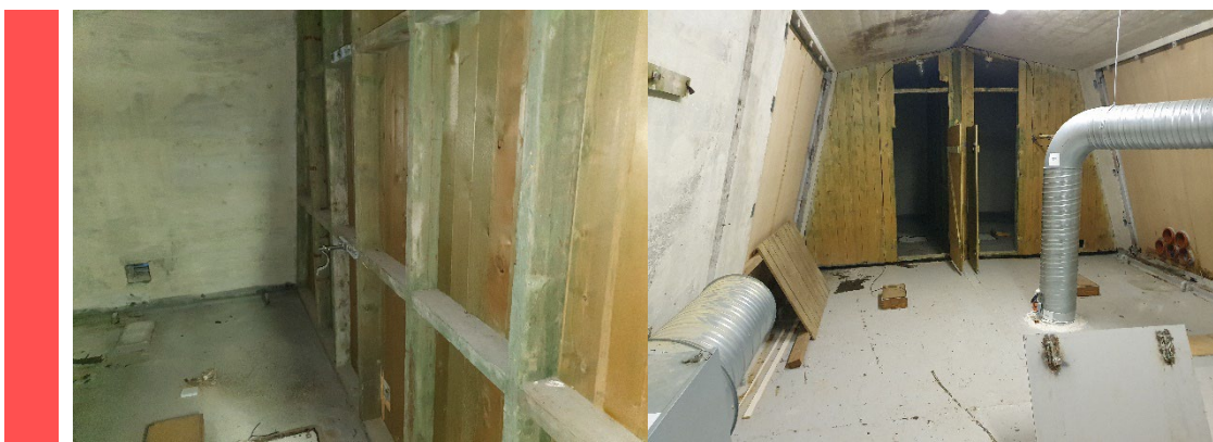
Figur 7-10 Lettvegger i CCA-impregnert trevirke på loft.
