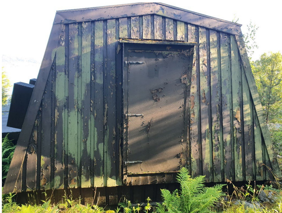
Figur 2-3 Radiolinjestasjonen er på tre etasjer. Her vist ved inngangspartiet (bilde Multiconsult).
