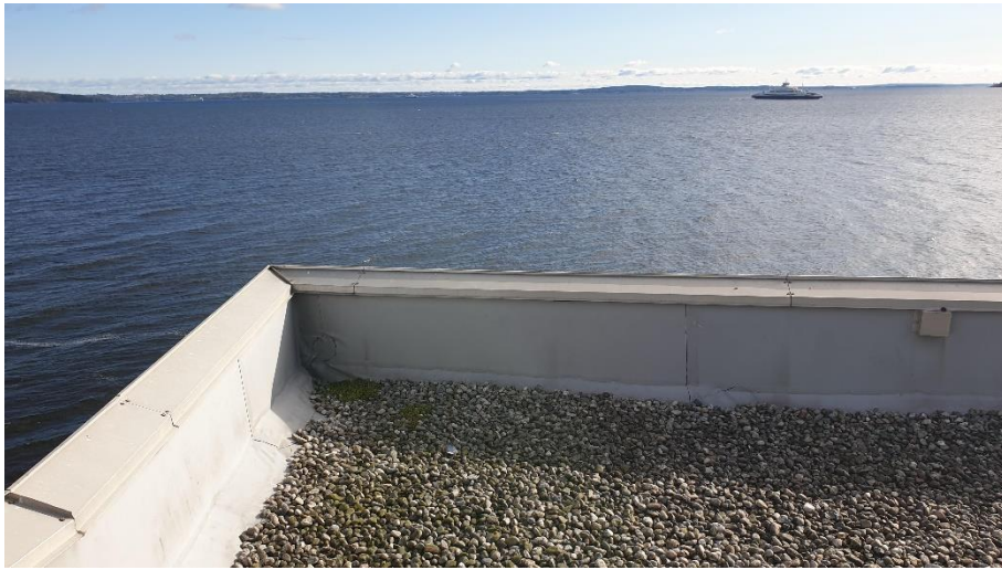
Taktekning over 3.etasje
