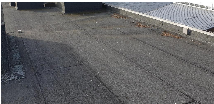
Taktekning over 4.etasje
