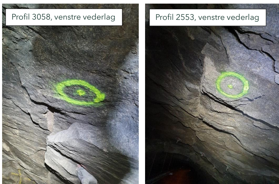
Figur 3: Eksempler på partier med bomt berg der det anbefales montering av bolt.
