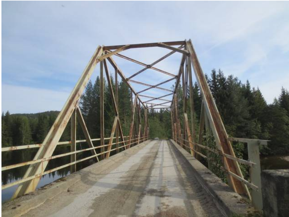
Bilde 13: Fagverk, slitelag
