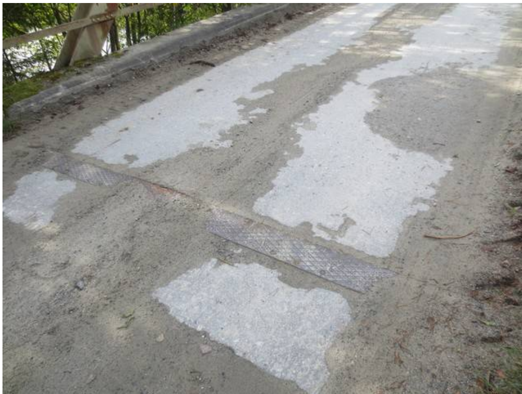
Bilde 18: Slitelag, fuge
