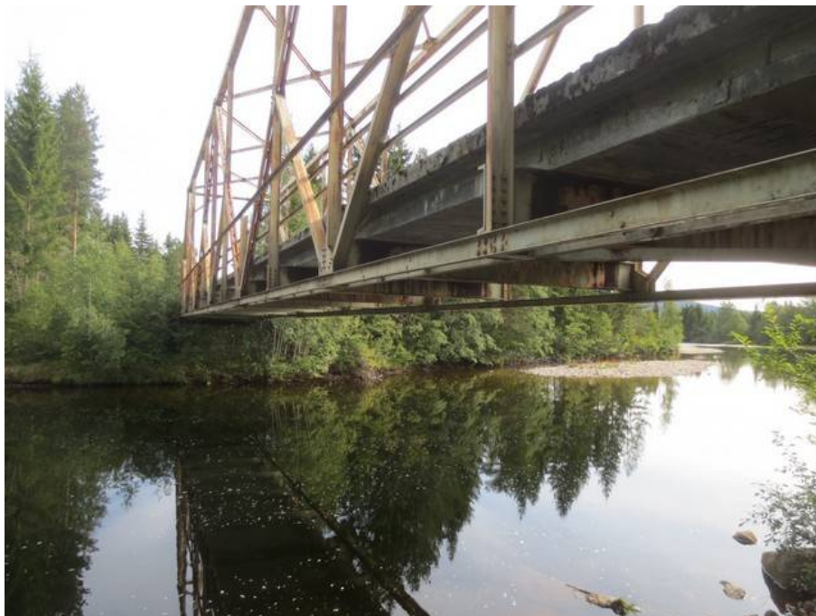
Bilde 14: Fagverk, brudekke
