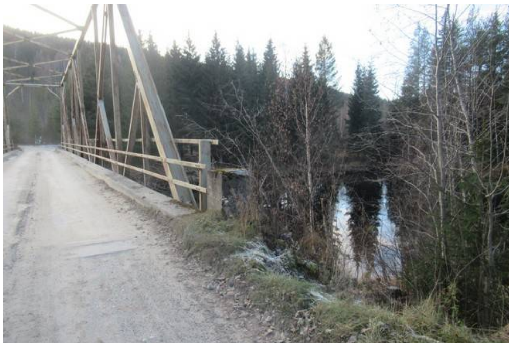
Bilde 27: Betongstabbe, rekkverk
