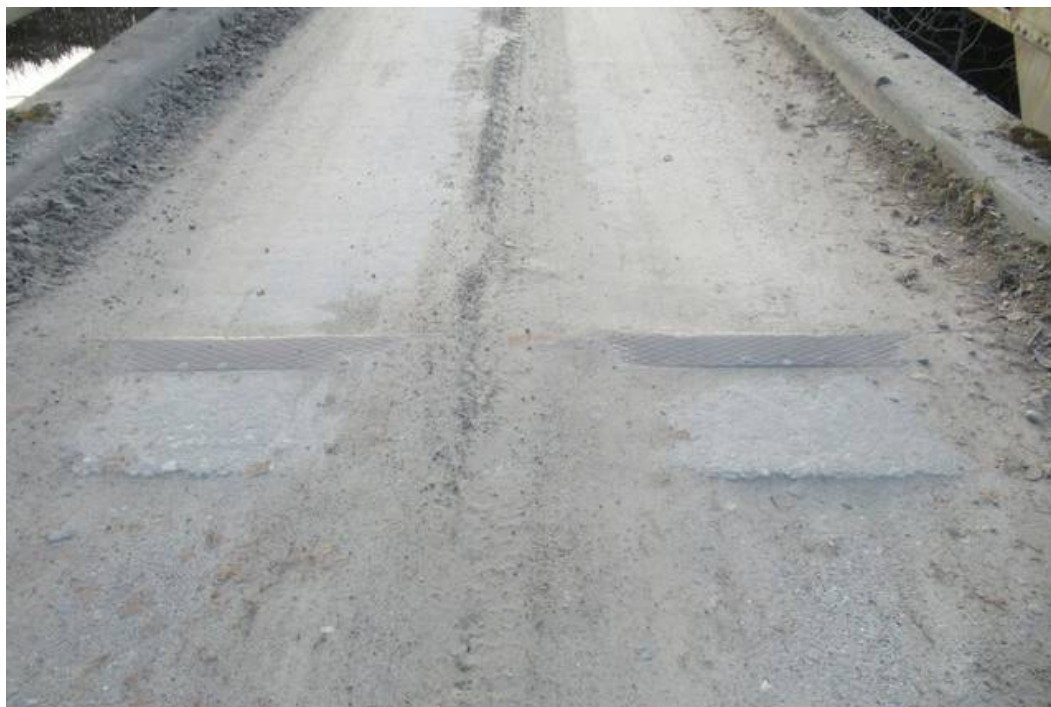
Bilde 21: Slitelag, fuge
