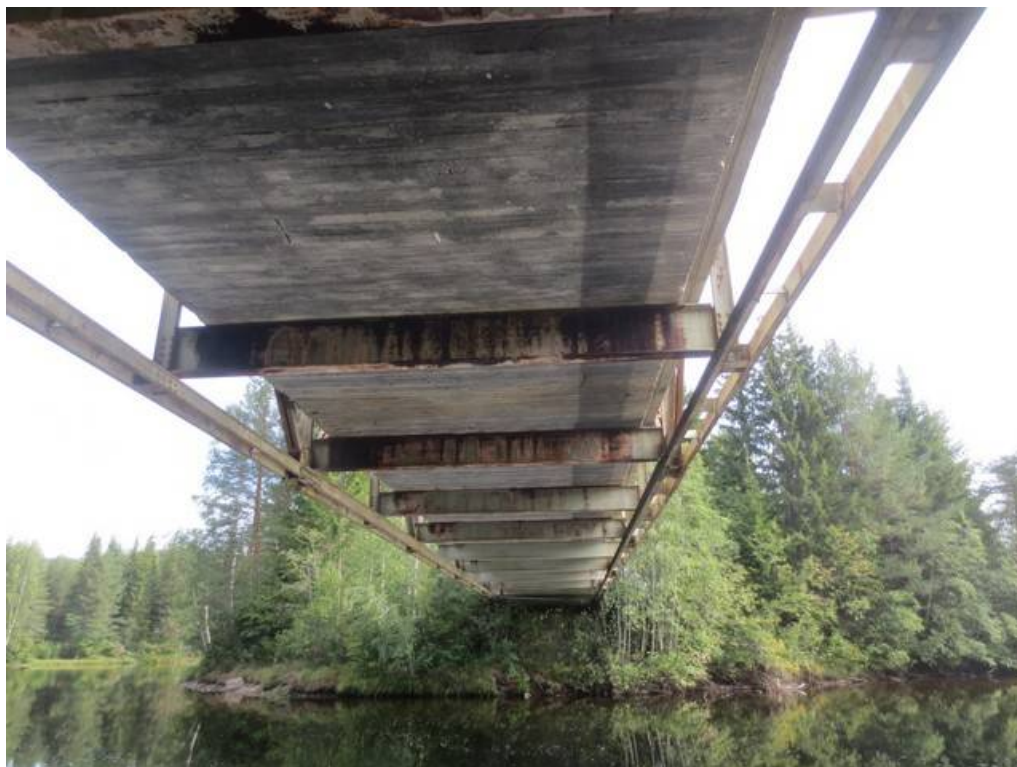
Bilde 15: Fagverk, brudekke
