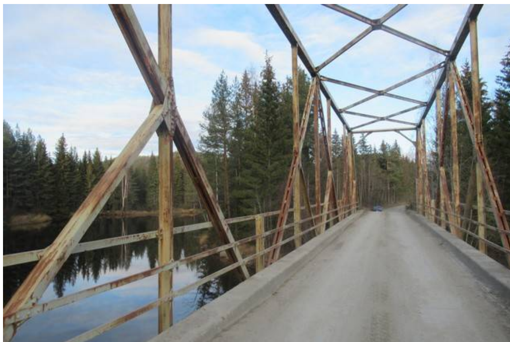
Bilde 16: Fagverk, slitelag
