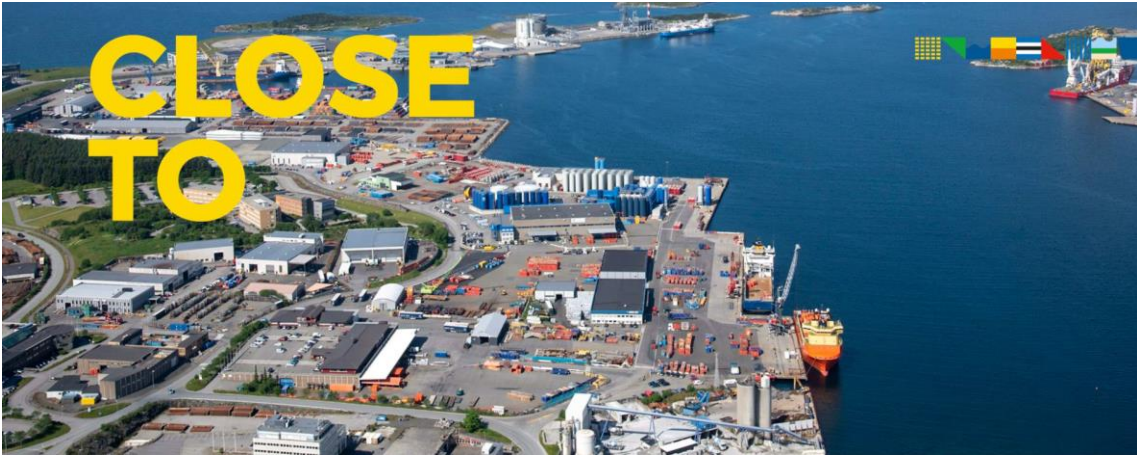
OTR – Offshore Terminal Risavika
