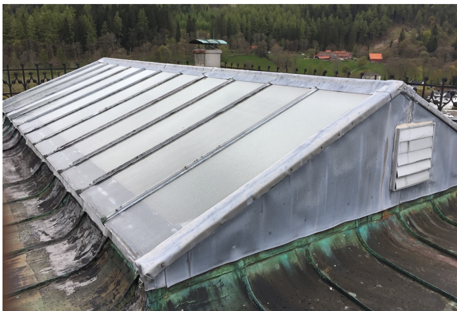
Eksisterende glasstak, ventil til røykavtrekk i gavl - foto Arkitektskap
