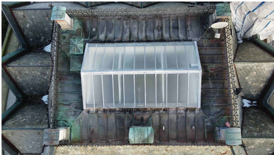
Eksisterende glasstak, sett ovenfra - foto Statsbygg
