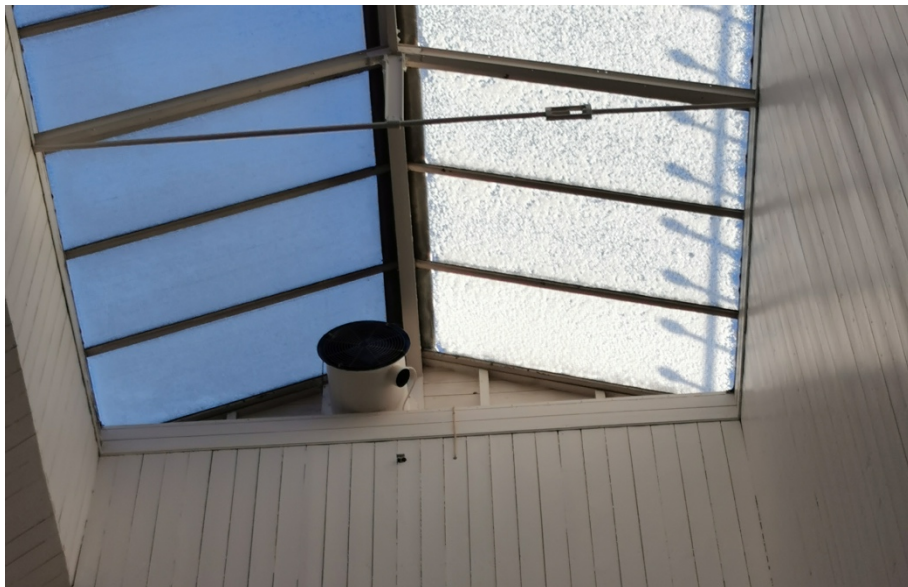
Glasstak og røykventilasjon i gavl - foto Arkitektskap
