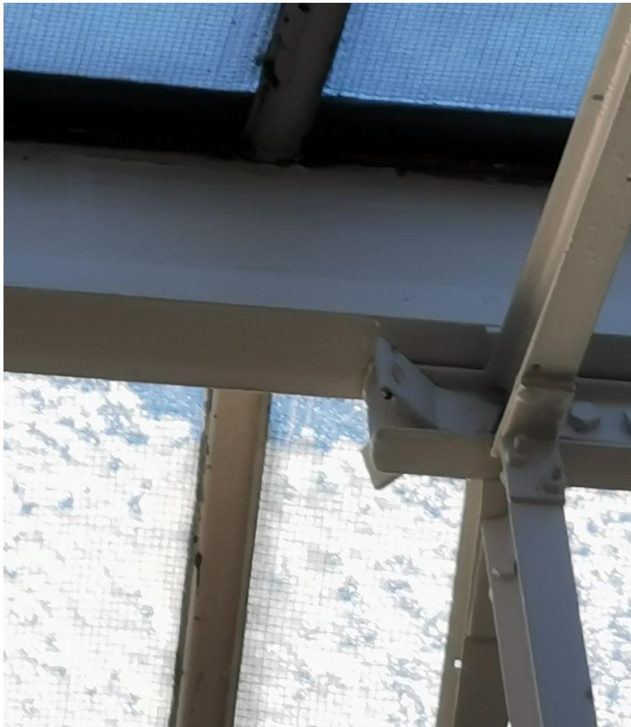
Detalj av gammel stålkonstruksjon med vinger for fester av gradsperrer, og "ny" mønedrager over - foto Arkitektskap
