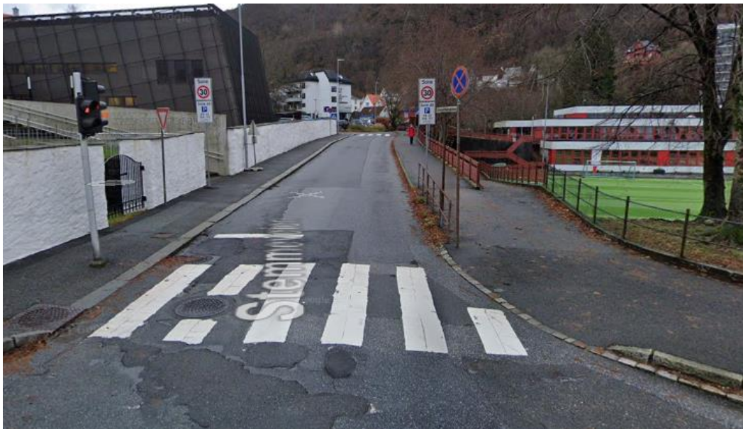
Figur 12. Kryssområdet Stemmeveien/Årstadveien må sikres bredde for avvikling av trafikk inn til Stemmeveien samtidig som buss venter på grønt lys, for å unngå stans/rygging etc. i kryssområdet. Foto: Google.
