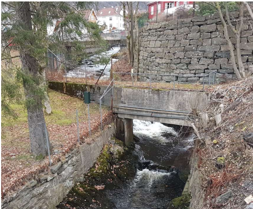
Figur 3-3: Bilder av bro 2 sett fra nedstrøms side. Foto: Asplan Viak AS.
