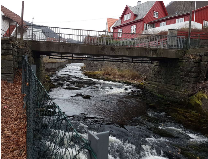
Figur 3-2: Bilder av bro 1 sett fra nedstrøms side. Foto: Asplan Viak AS.
