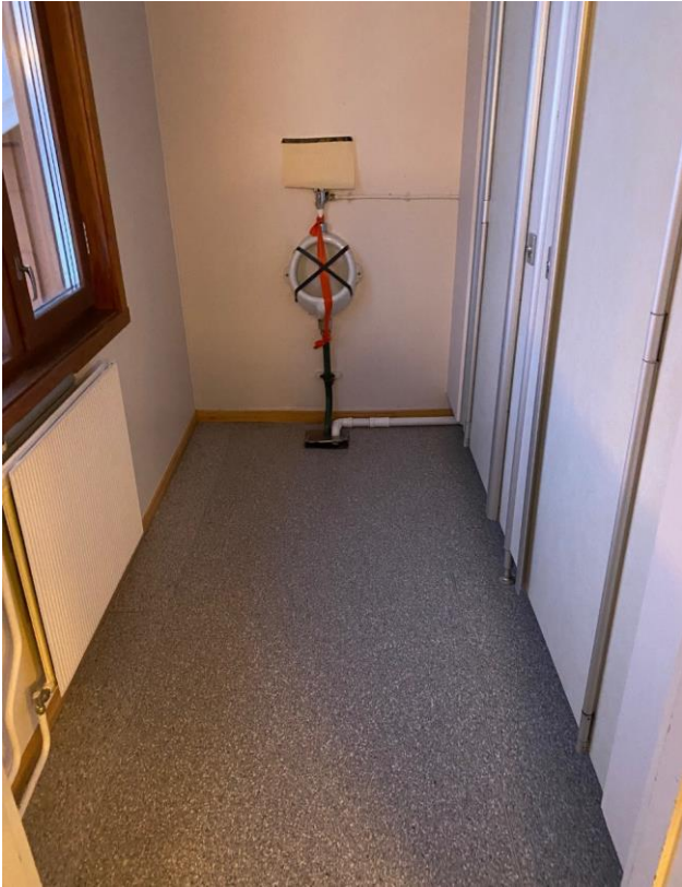
Deler av sanitærrrom 2. etg.
