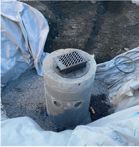
Bilde 1: Eksempelbilde av sandfangskum med rennestensluk (Foto: Tiril Bjørsum, 2022)
