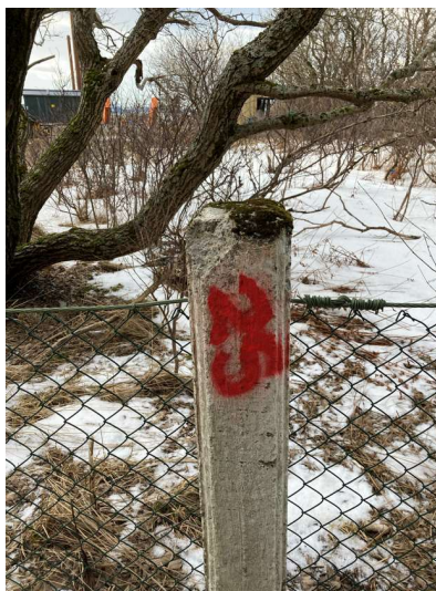
Bilde 48. Prøve av betong fra gjerdestolper i Holmsveien 2057 (prøve H25). Betongen er ren (konsentrasjoner under normverdi)
