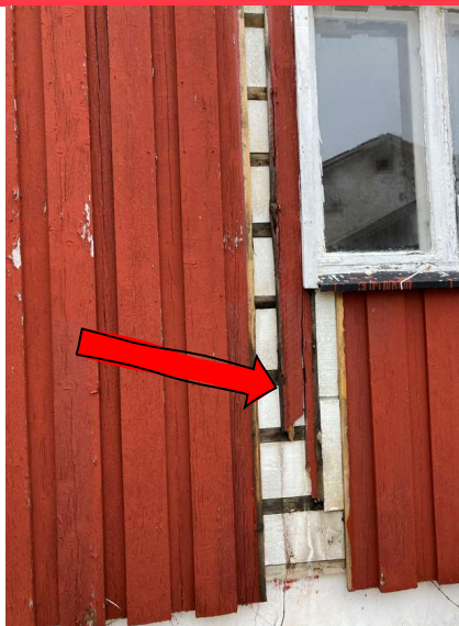
Bilde 25. EPS-isolasjon (isopor) bak veggkledning på bolighus i Holmsveien 2057
