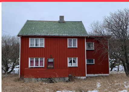
Bilde 6. Eternittskifer på tak, enebolig, Holmsveien 2057
