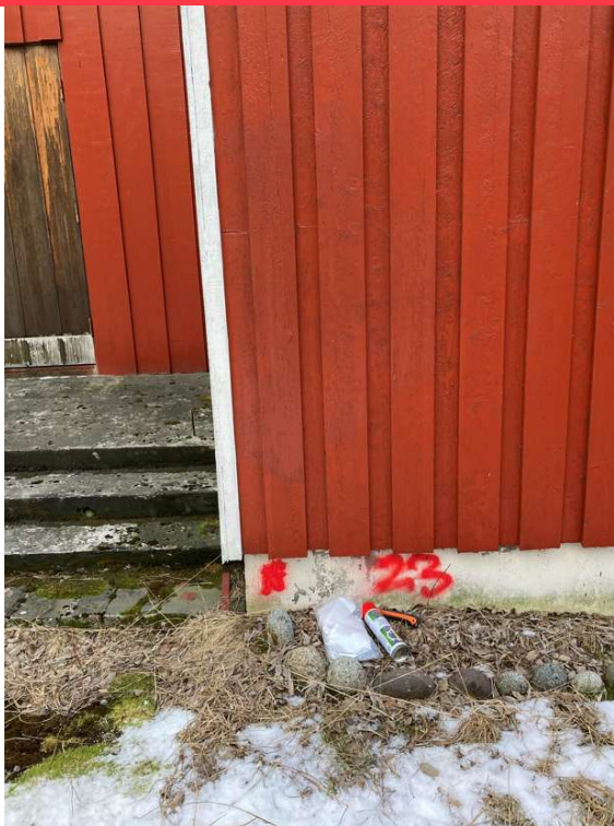
Bilde 40. Hvit maling på grunnmur, Holmsveien 2057 (prøve H23) må håndteres som farlig avfall med sink
