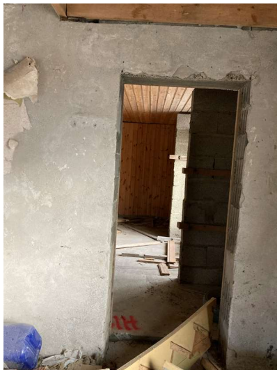
Bilde 45. Prøve av betonggulv fra tilbygg (prøve H19) og original bygningsdel (prøve H20). Betongen er ren (konsentrasjoner under normverdi)
