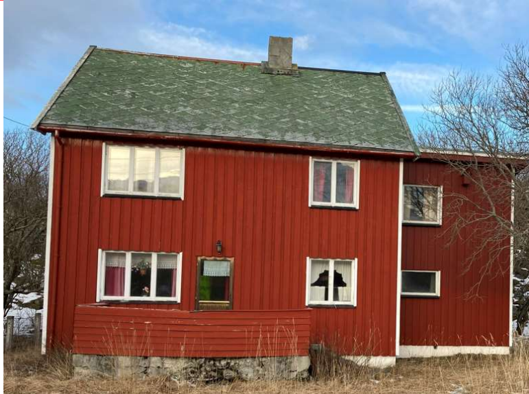
Bilde 52. Pipeløp tilkn. Holmsveien 2057. Pipen feies før de rives, og aske og tjære fra pipene skal leveres godkjent mottak. Innerste laget med teglstein i pipene vil også kunne inneholde noe sot og denne håndteres derfor som lettere forurenset
