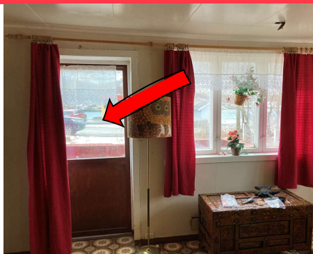
Bilde 29. Balkongdør i Holmsveien 2057 skal håndteres som farlig avfall med klorparafiner (Riis isoler -80)
