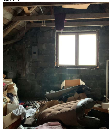
Bilde 38. Tekstil og møbler på loft i Holmsveien 2057
