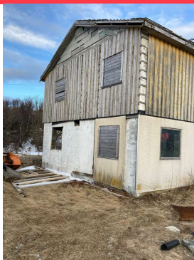
Bilde 30. Isolerglassruter tilknyttet Holmsveien 2059 skal håndteres som klorparafinholdige (Thermoglass -88)
