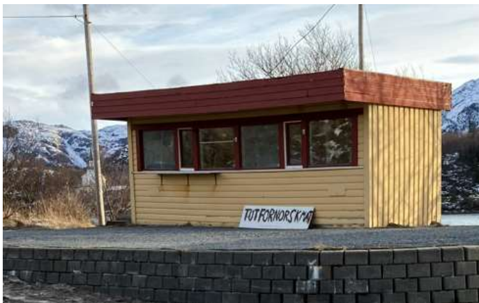
Bilde 32. Udaterte «Nordterm» isolerglassruter tilknyttet kiosk skal håndteres som klorparafinholdige
