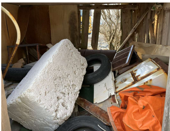
Bilde 37. EPS-isolasjon sorteres ut og leveres som farlig avfall med bromerte flammehemmere
