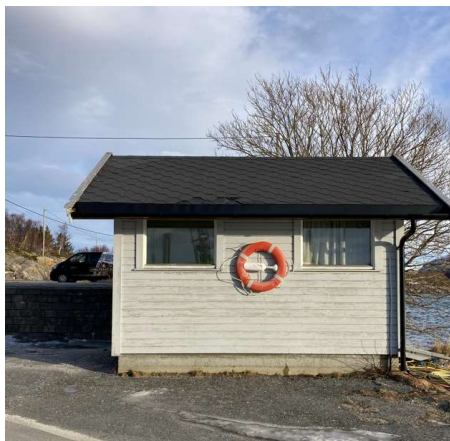
Bilde 31. Isolerglassruter på WC-bygg kan håndteres som ikke-farlig avfall
