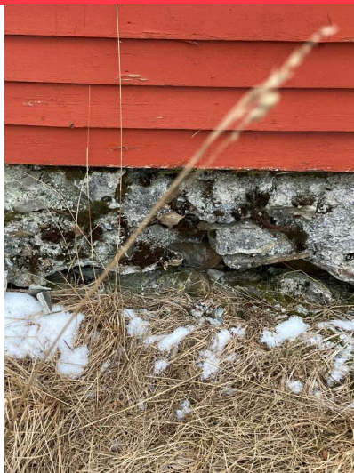
Bilde 41. Prøve av betong fra terrasse i Holmsveien 2057 (prøve H12). Betongen er ren (konsentrasjoner under normverdi)
