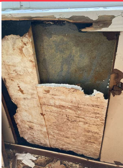
Bilde 26. EPS-isolasjon (isopor) avdekket bak innvendige sponplater i 1. og 2. etasje på bolighus i Holmsveien 2057
