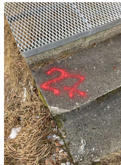
Bilde 49. Prøve av betong fra kiosk (prøve H27). Betongen er forurenset med krom (VI) over normverdi
