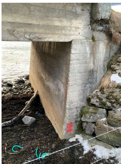
Bilde 51. Prøve av betong fra kjørebri (prøve B1). Betongen er ren (konsentrasjoner under normverdi)
