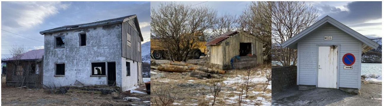
Bilde 4: Enebolig med tilhørende uthus/skur (Holmsveien 2059), samt offentlig WC, gnr./bnr. 14/15
