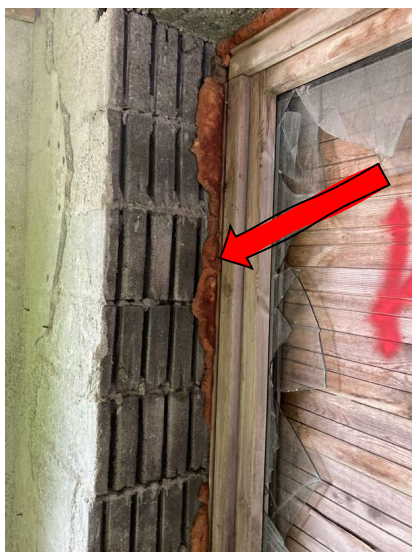
Bilde 28. PUR-skum som tetning, Holmsveien 2059
