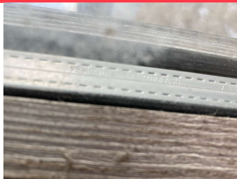
Bilde 30. Isolerglassruter tilknyttet Holmsveien 2059 skal håndteres som klorparafinholdige (Thermoglass -88)
