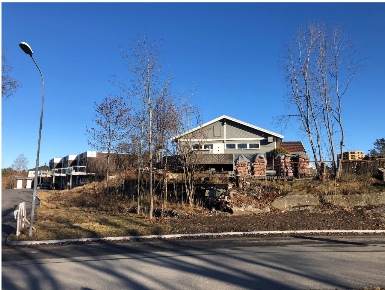
Bilde av eksisterende bygningsmasse på tomten, sett fra Balders vei.
