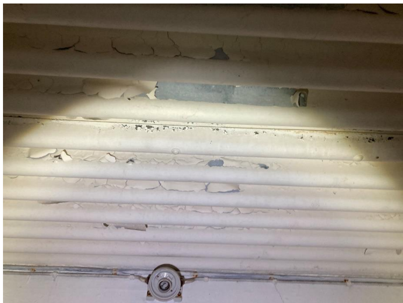
Figur 3: Metallplater i himlingen i bygg 5
