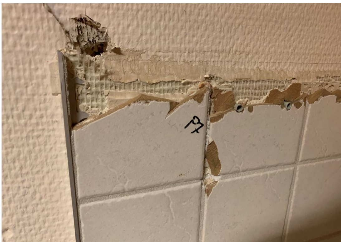
Bilde 6 – Bilde fra prøve 7. Fuger/lim på flis på kjøkken ble analysert for tungmetaller og klorparafiner. Prøven viser ingen forekomst av klorparafiner, og en forekomst av tungmetaller under normverdi for forurensete masser. Flisene kan håndteres som rene masser.
