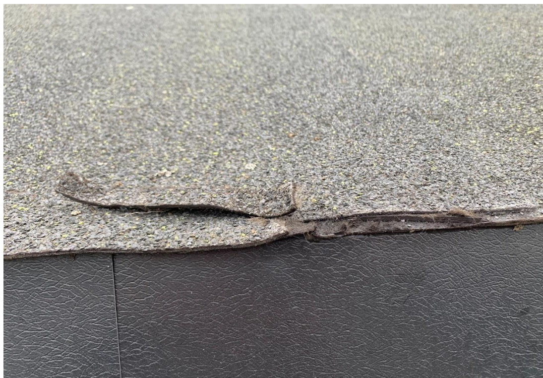
Bilde 9 – Bilde fra prøve 10. Takpapp ble analysert for PAH og THC. Prøven viser en forekomst av PAH og THC under grenseverdi for farlig avfall. Takpappen kan leveres som ordinært avfall.
