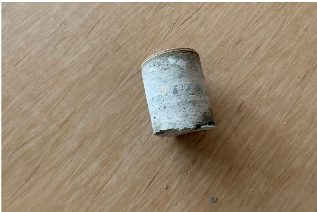
Bilde 5 – Bilde fra prøve 6. En kjerne fra betongdekket ble tatt ut og analysert for tungmetaller inkl. Krom VI. Prøven viser en forekomst av tungmetaller under normverdi for forurensete masser. Betongplata kan behandles som rene masser.
