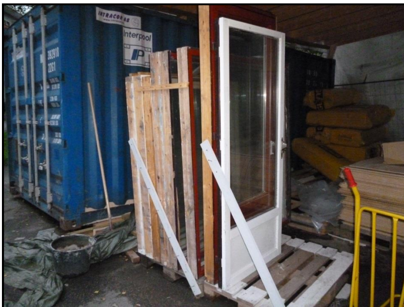
Figur 1: Slik kan vinduer og balkongdører klargjøres for transport.
