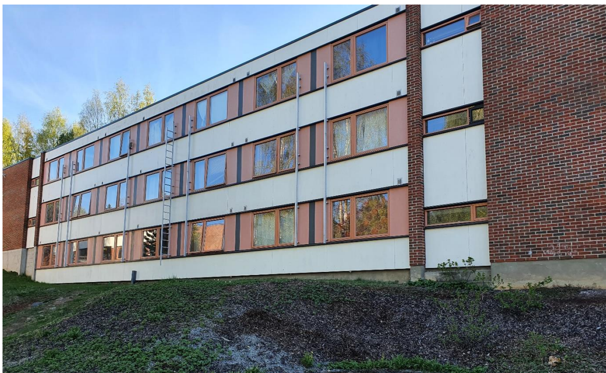
Figur 3 Bildet viser fasade mot vest (Tranbylia 7). Samtlige fasader på begge boligblokker er gjennomgående likt bygget opp.
