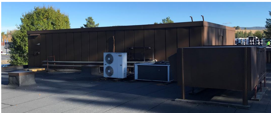
Teknisk rom for 360.15 og .14
