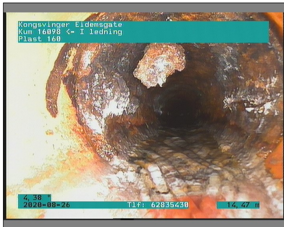
Foto: 1_1_7_26082020_093046_A.JPG 14,47m, Materialendring til Støpejern
