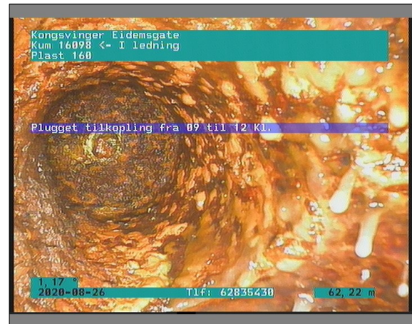
Foto: 1_1_40_26082020_102146_A.JPG 62,22m, Plugget tilkopling fra 09 til 12 Kl.
