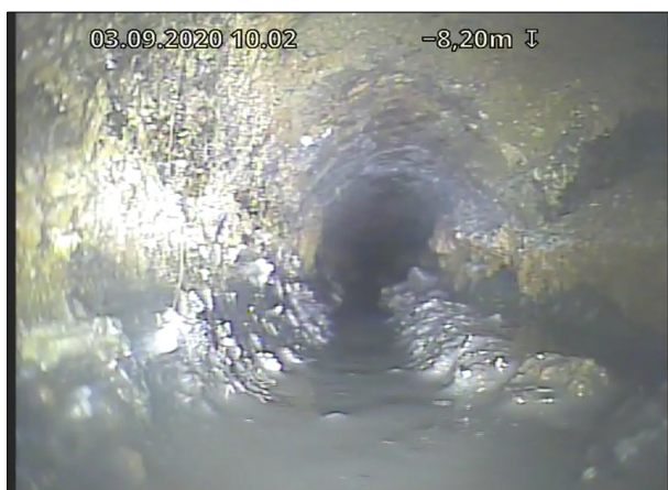
Foto: S_Sectionname_Stiger trappegang_Gren hovedstrekk_20200911_1409_A.jpg 0,8m, Sedimentering, dybde på avsetning er mellom 15-30%, fra 04 til 08 Kl., Andre, Start
