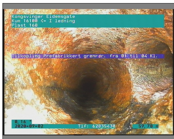
Foto: 4_1_22_02092020_104101_A.JPG 59,78m, Tilkopling Prefabrikkert grenrør. fra 01 til 04 Kl., Spillvann innkoblet ?
