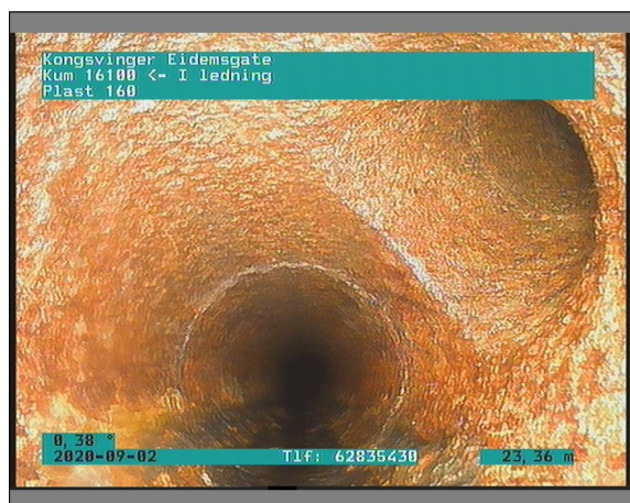
Foto: 4_1_9_02092020_102211_A.JPG 23,56m, Tilkopling Prefabrikkert grennrør. fra 01 til 04 Kl.
