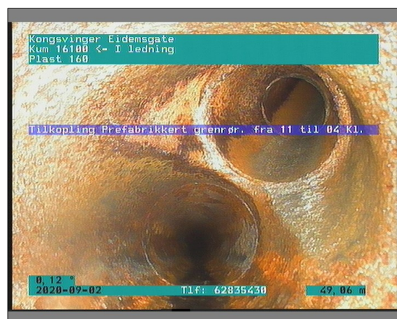
Foto: 4_1_18_02092020_103547_A.JPG 49,06m, Tilkopling Prefabrikkert grennrør. fra 11 til 04 Kl.
