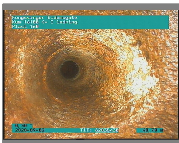
Foto: 4_1_17_02092020_103507_B.JPG 48,52m, Tilkopling Prefabrikkert grennrør. fra 10 til 01 Kl.
