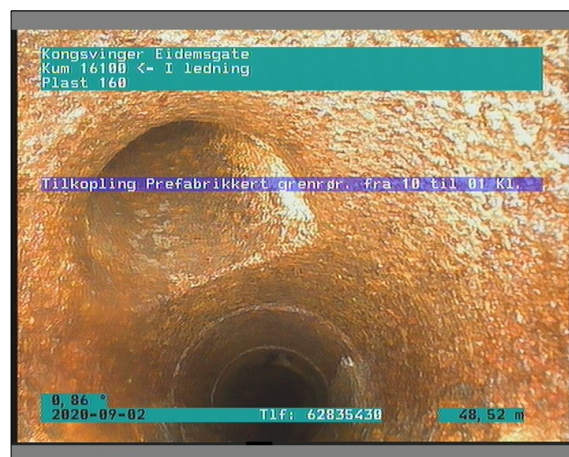
Foto: 4_1_17_02092020_103454_A.JPG 48,52m, Tilkopling Prefabrikkert grennrør. fra 10 til 01 Kl.
