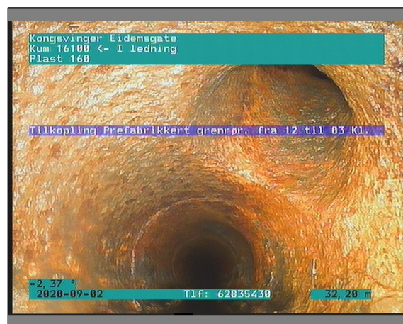
Foto: 4_1_11_02092020_102553_A.JPG 32,19m, Tilkopling Prefabrikkert grennrør. fra 12 til 03 Kl.
