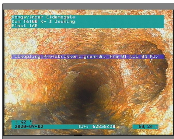
Foto: 4_1_23_02092020_104229_A.JPG 60,26m, Tilkopling Prefabrikkert grenrør. fra 01 til 04 Kl.
