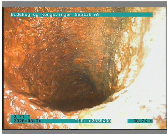
Foto: 1_1_15_26082020_132108_A.JPG 30,84m, Tilkopling Prefabrikkert grennrør. fra 01 til 04 Kl.
