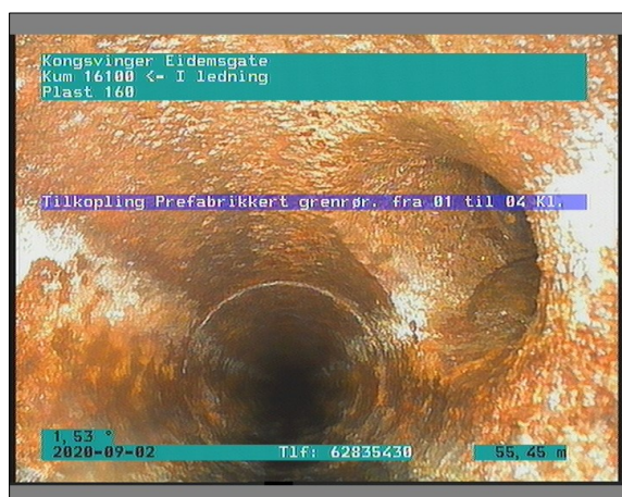
Foto: 4_1_20_02092020_103814_A.JPG 55,56m, Tilkopling Prefabrikkert grenrør. fra 01 til 04 Kl.
