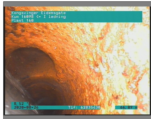
Foto: 1_1_45_26082020_105013_A.JPG 66,91m, Tilkopling Prefabrikkert grennrør. fra 08 til 12 Kl.
