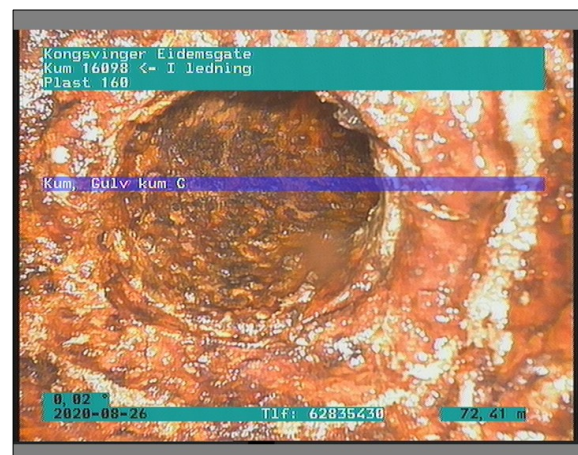
Foto: 1_1_48_26082020_111651_A.JPG 72,41m, Kum, Gulv kum C
