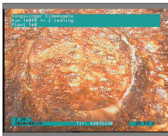
Foto: 1_1_28_26082020_100705_A.JPG 49,93m, Tilkopling Andre, fra 10 til 02 Kl., Stakegren i Gulvkum B
