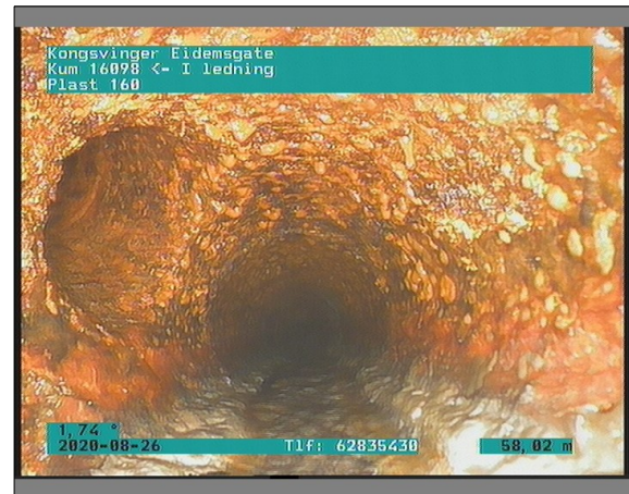
Foto: 1_1_34_26082020_101528_A.JPG 58,29m, Tilkopling Prefabrikkert grenrør. fra 08 til 11 Kl.
