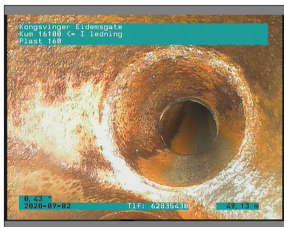
Foto: 4_1_18_02092020_103559_B.JPG 49,06m, Tilkopling Prefabrikkert grenrør. fra 11 til 04 Kl.
