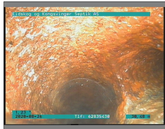
Foto: 1_1_15_26082020_132128_B.JPG 30,84m, Tilkopling Prefabrikkert grennrør. fra 01 til 04 Kl.
