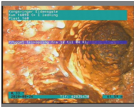
Foto: 1_1_38_26082020_102030_A.JPG 61,59m, Plugget tilkopling fra 12 til 04 Kl.
