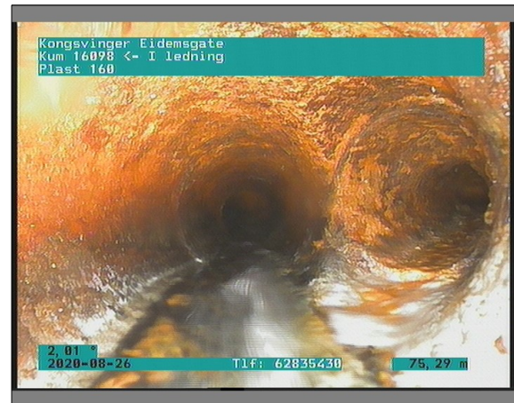
Foto: 1_1_49_26082020_113206_B.JPG 75,38m, Tilkopling Prefabrikkert grenrør. fra 12 til 06 Kl.
