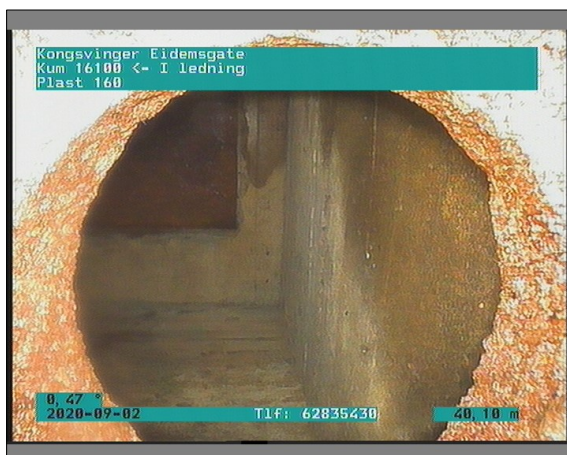
Foto: 4_1_15_02092020_103057_A.JPG 39,97m, Tilkopling Andre, fra 10 til 02 Kl., Stakeluke i kum
