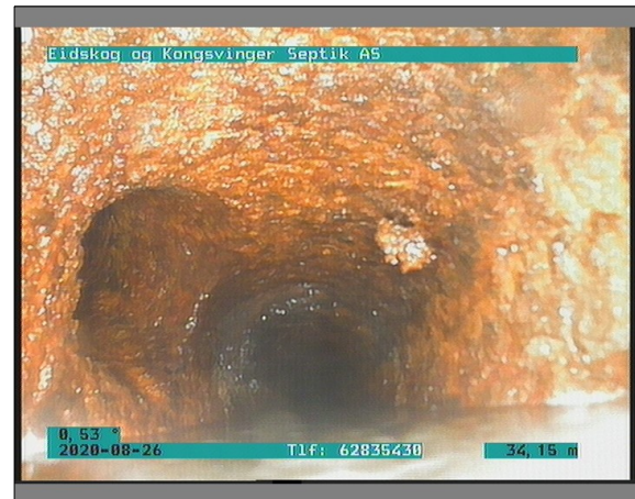
Foto: 1_1_18_26082020_131734_B.JPG 34,52m, Tilkopling Prefabrikkert grenrør. fra 09 til 11 Kl.
