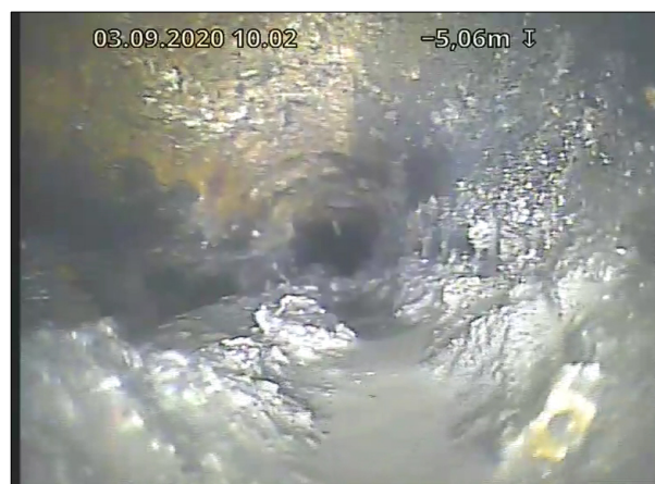
Foto: S_Sectionname_Stiger trappegang_Gren hovedstrekk_20200911_1410_B.jpg 0,8m, Sedimentering, dybde på avsetning er mellom 15-30%, fra 04 til 08 Kl., Andre, Start
