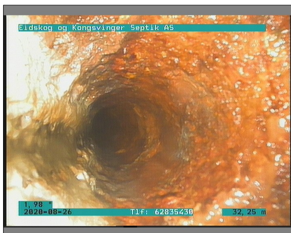
Foto: 1_1_17_26082020_131854_A.JPG 32,36m, Tilkopling Prefabrikkert grennrør. fra 09 til 11 Kl.
