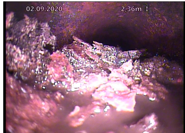
Foto: S_Sectionname_75 mm stiger_Hovedstrekk_20200911_1346_A.jpg 2,4m, Sedimentering,dybde på avsetning er mer en 30%, fra 03 til 09 Kl., Andre
