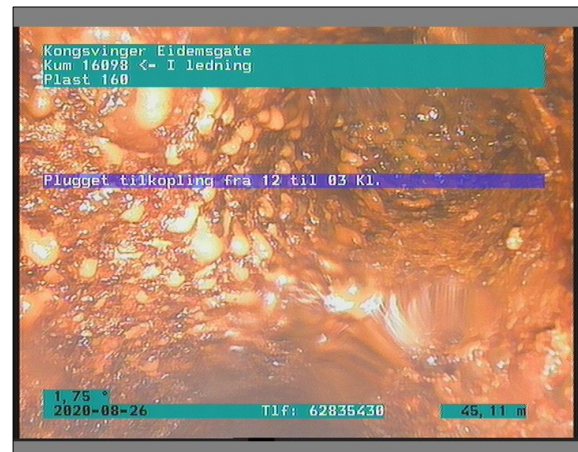
Foto: 1_1_24_26082020_100122_A.JPG 45,11m, Plugget tilkopling fra 12 til 03 Kl.
