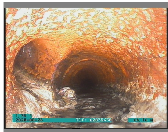
Foto: 1_1_42_26082020_102601_A.JPG 66,3m, Tilkopling Prefabrikkert grenrør. fra 08 til 11 Kl.
