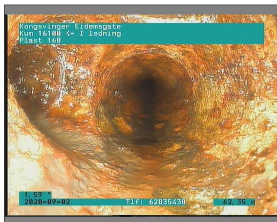
Foto: 4_1_26_02092020_104550_B.JPG 62,5m, Tilkopling Prefabrikkert grenør. fra 07 til 11 Kl.
