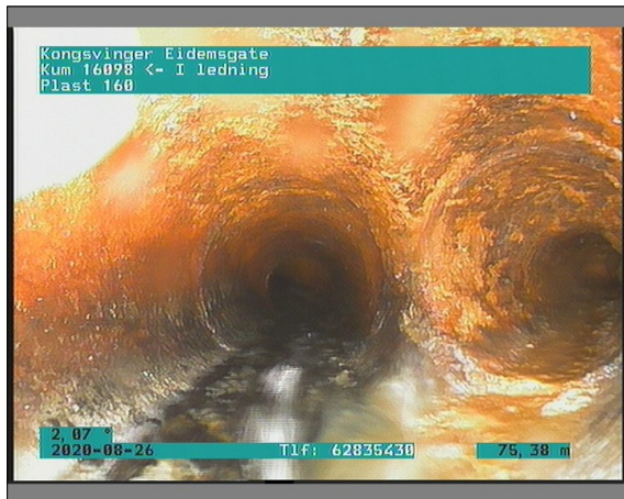
Foto: 1_1_49_26082020_112319_A.JPG 75,38m, Tilkopling Prefabrikkert grenrør. fra 12 til 06 Kl.
