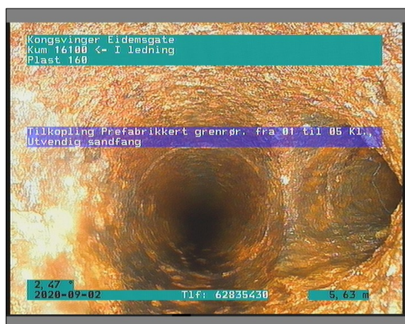
Foto: 4_1_4_02092020_101242_A.JPG 5,63m, Tilkopling Prefabrikkert grenrør, fra 01 til 05 Kl., Utvendig sandfang
