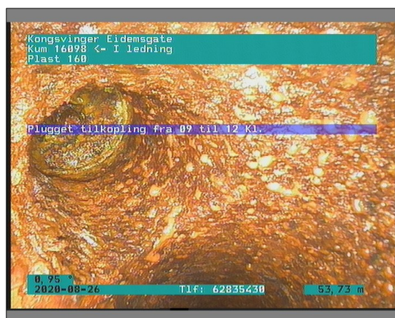
Foto: 1_1_31_26082020_101122_A.JPG 53,73m, Plugget tilkopling fra 09 til 12 Kl.
