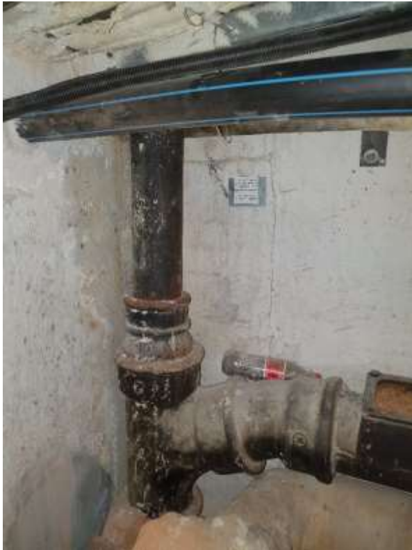
Oppstikk strekk 1 i kulvert. Start rørfornyng
