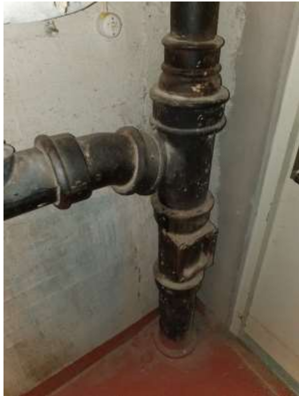
Oppstikk strekk 2 i kulvert. Start rørfornyng
