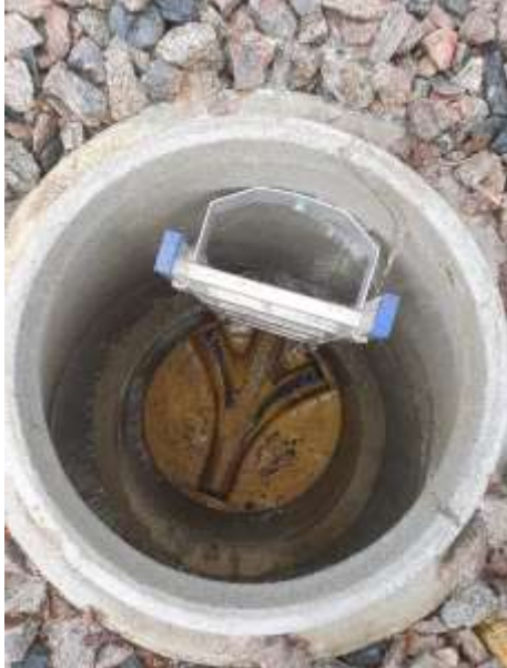
Strekk 1: Kum 16098 Start inspeksjon
