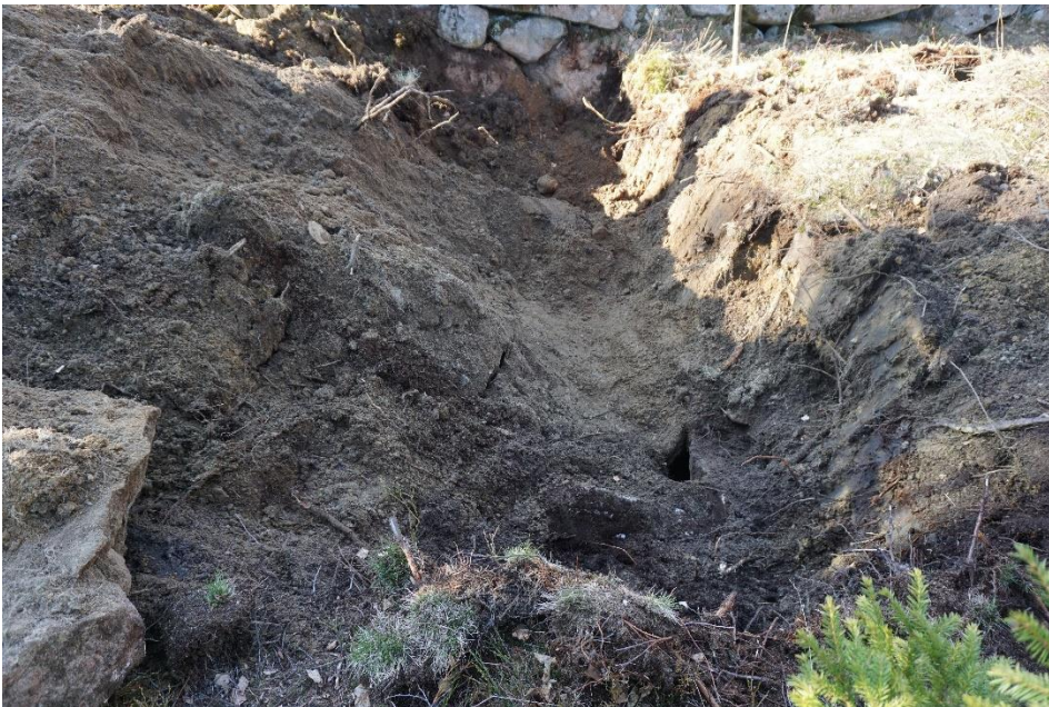
Sjaktning (2) på hoveddammen sett mot nedstrøms. Grusige sandige masser med stein i damkroppen. Nedstrøms mur synes i bakkant.
