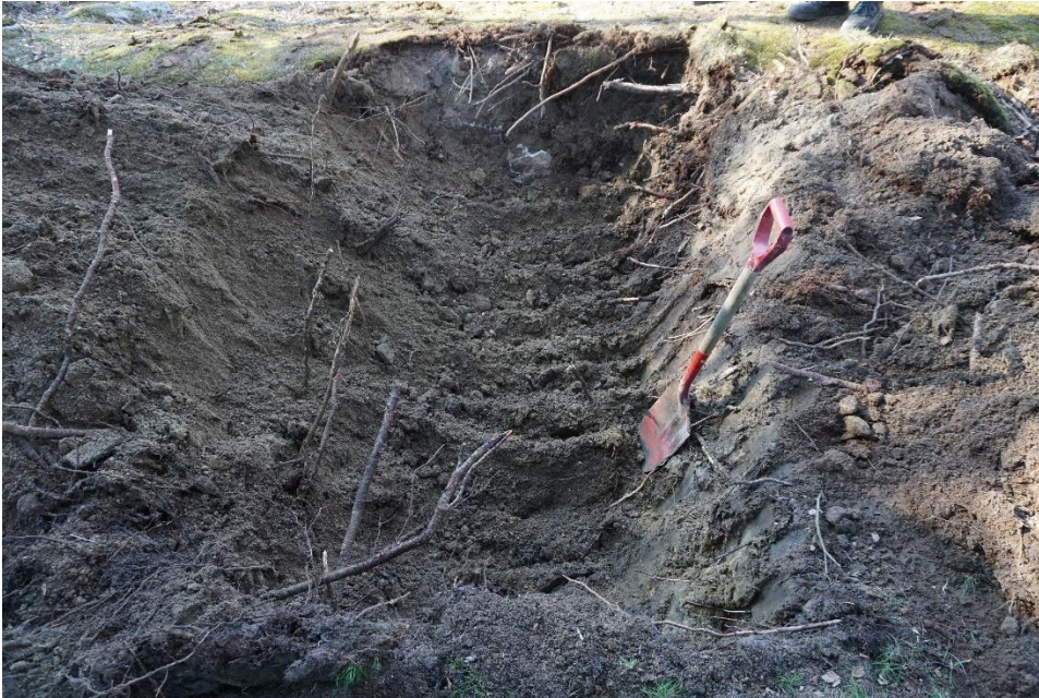
Sjaktning (1) på hoveddammen sett mot nedstrøms. Grusige sandige masser med stein i damkroppen. Nedstrøms mur synes i bakkant.
