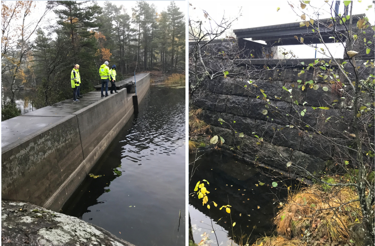
Figur 2-2: Tvetervann murt steindam med overløp. Til venstre: oppstrømside som viser betongplate. Til høyre: nedstrømside som viser murdammen.
