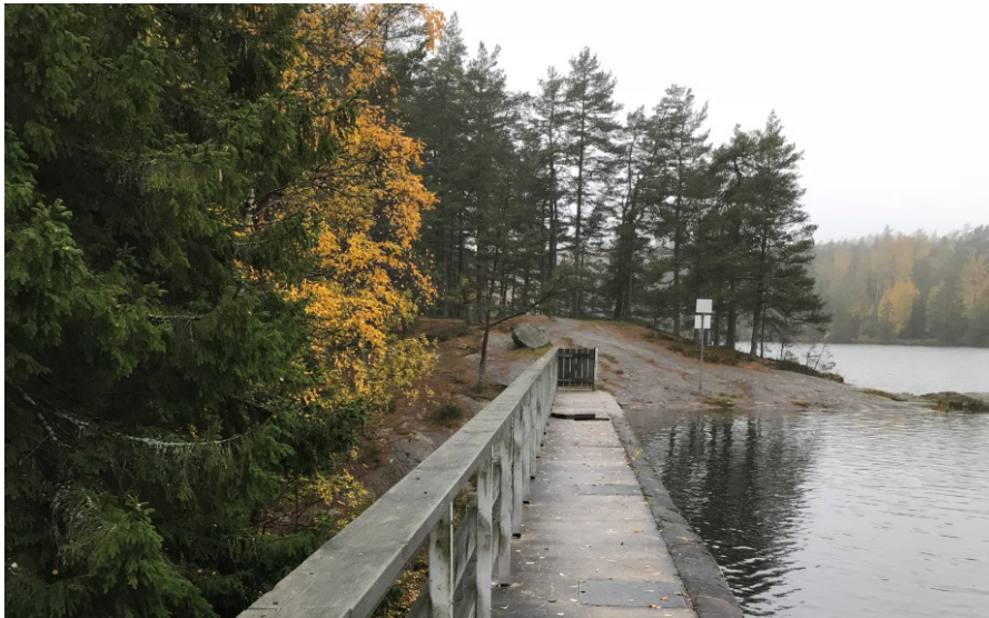
Figur 2-2: Terreng (rensket fjell) ved flomløp på Borredalsdammen.
