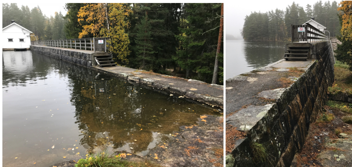
Figur 2-1: Borredalsdammen murt steindam med overløp.
