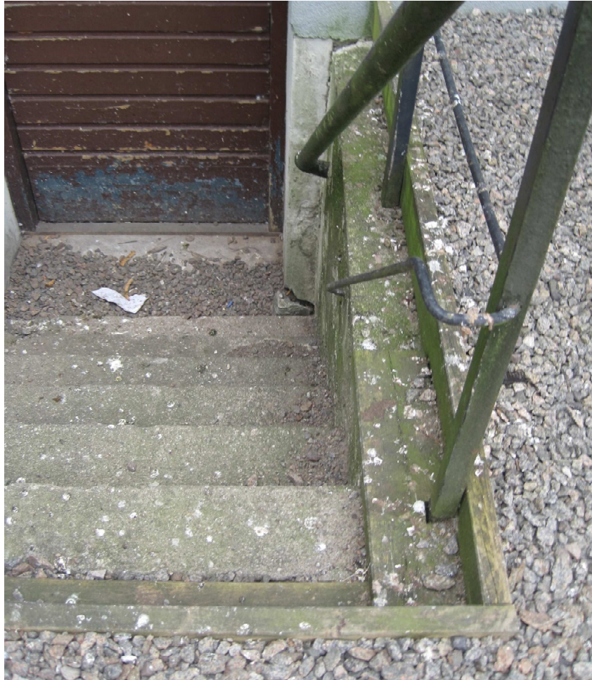
Bilde 14 Impregnert trevirke ved nedgang til kjeller.
