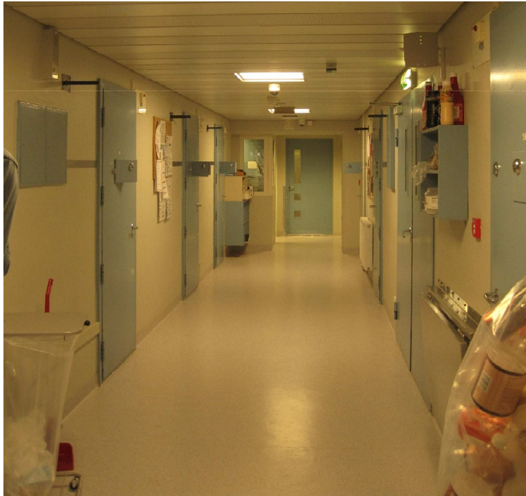
Bilde 10 Vinylbelegg i korridor, samme belegg i celler.
