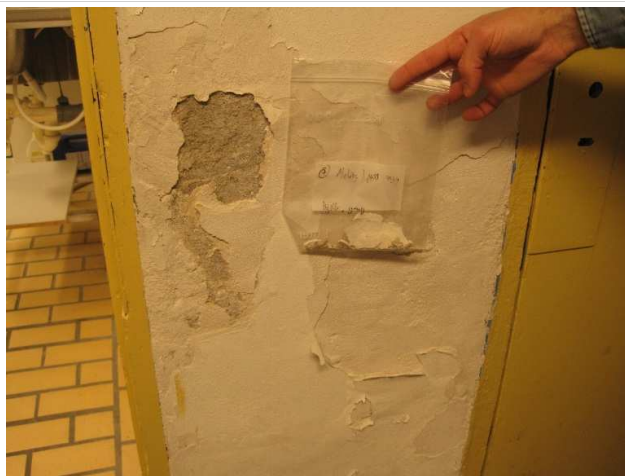
Prøve 7: Maling og puss på vegg i kjeller, i gang.
