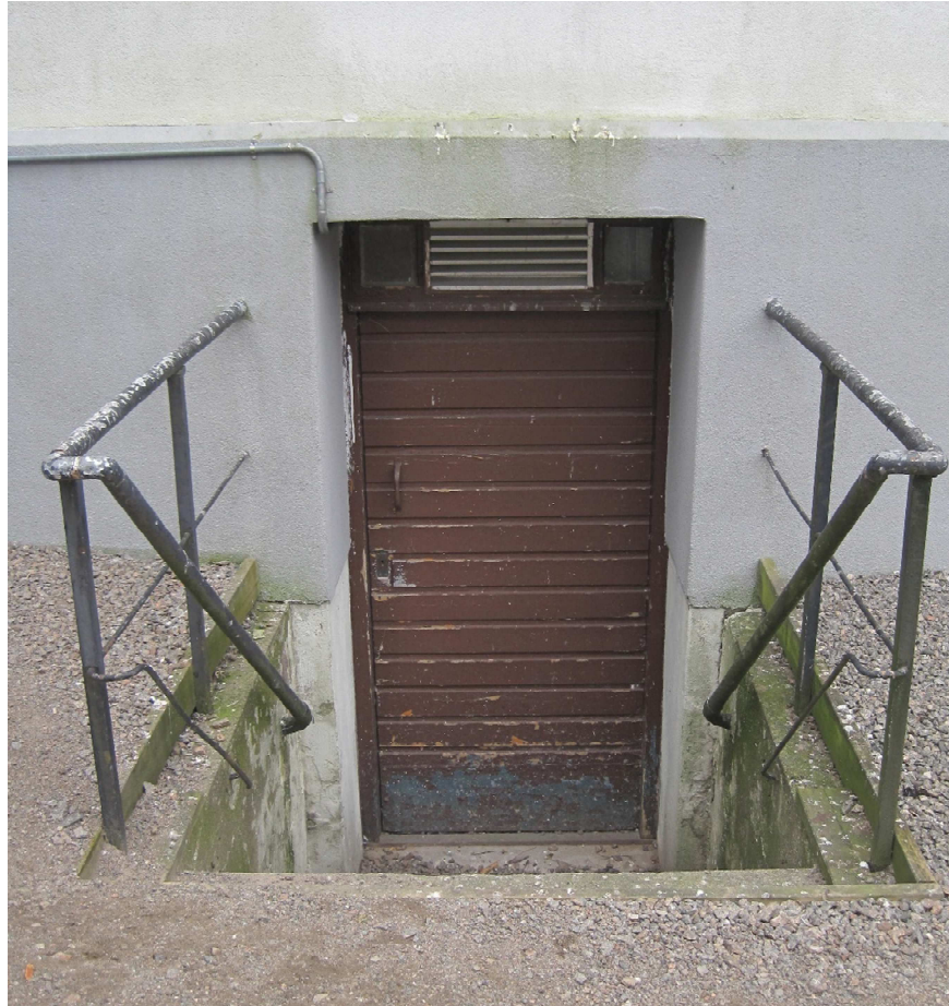
Bilde 12 Ytterdør ut fra kjeller, malingslag på dør med innhold av tungmetaller og PCB.
