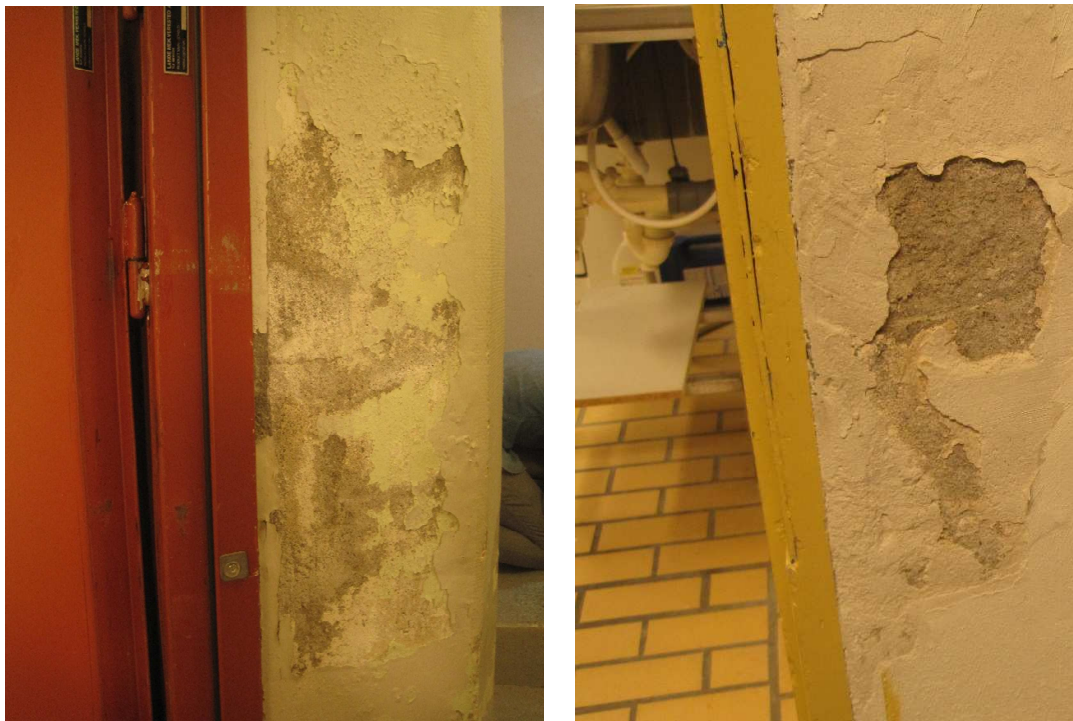
Bilde 1 og 2 Maling på betongvegger i kjeller.
