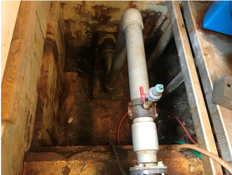
Figur 1: Innløp med pumpeump.
