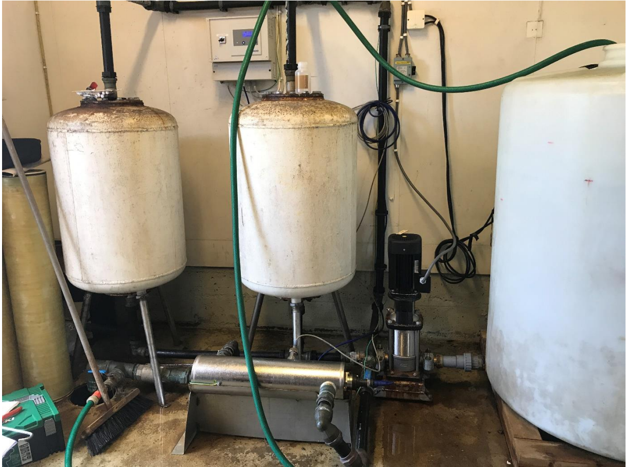
Figur 7: 2 stk. marmorfilter, UV og utløpspumpe
