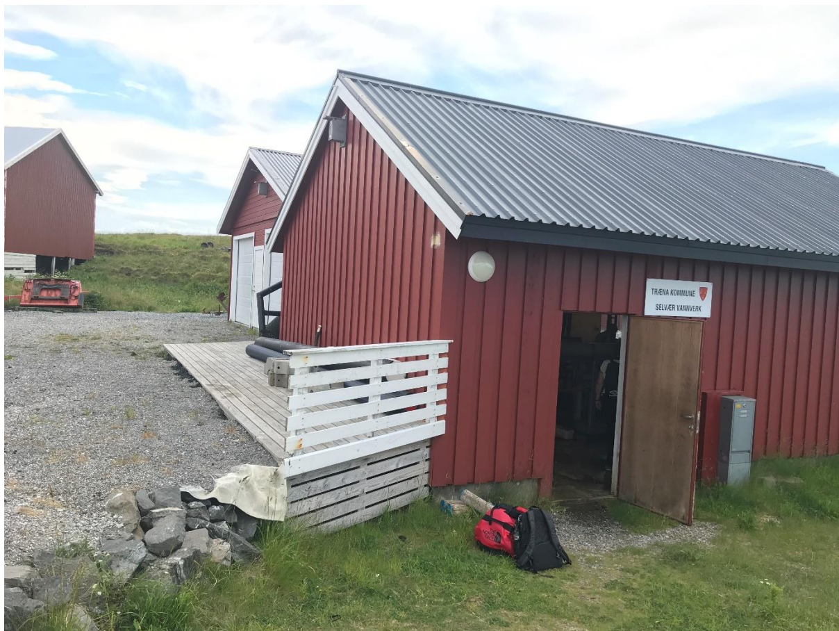
Figur 1: Selvær vv. Ny port skal monteres på kortsida (på samme nivå som gulvet innenfor) før montering av nytt prosessutstyr.
