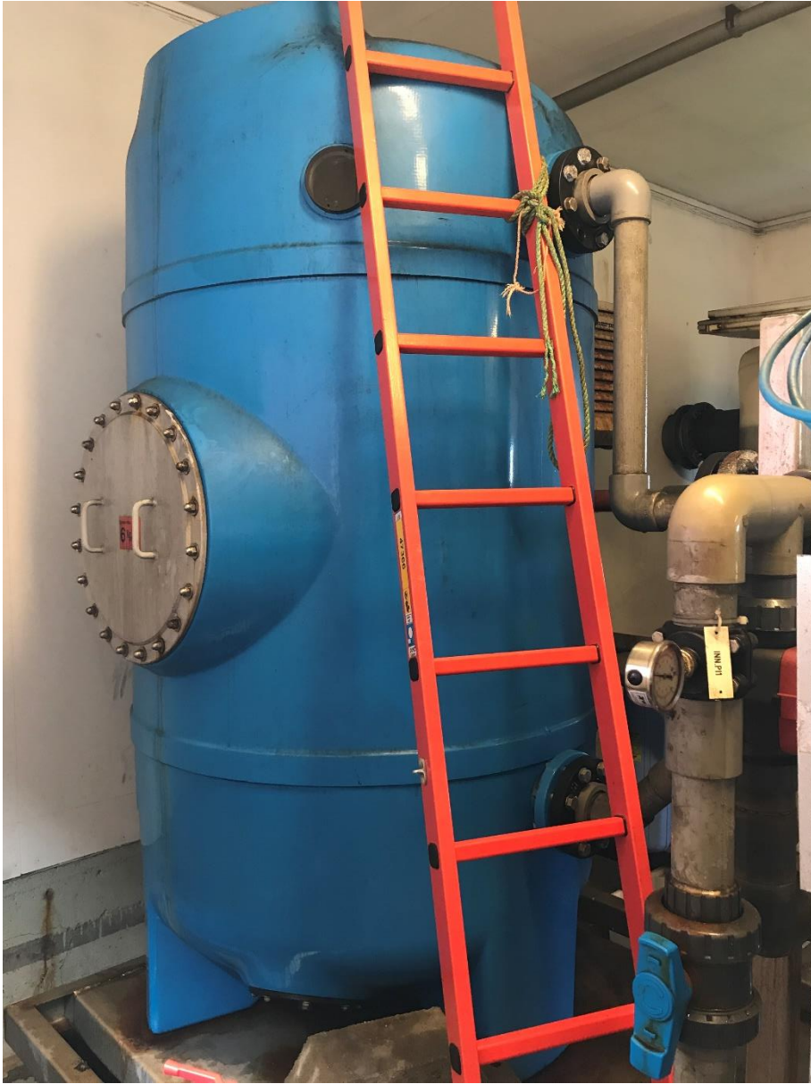
Figur 4: Sandfilter – står på rist over innløpsgrav
