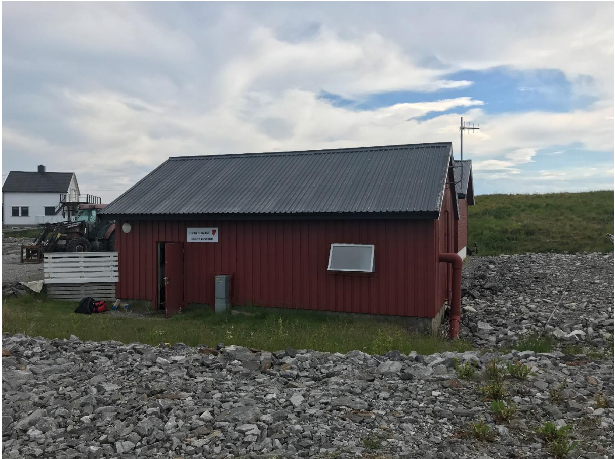
Figur 15: Vannverksbygget med området rundt. El.tavle står i bygget bak.
