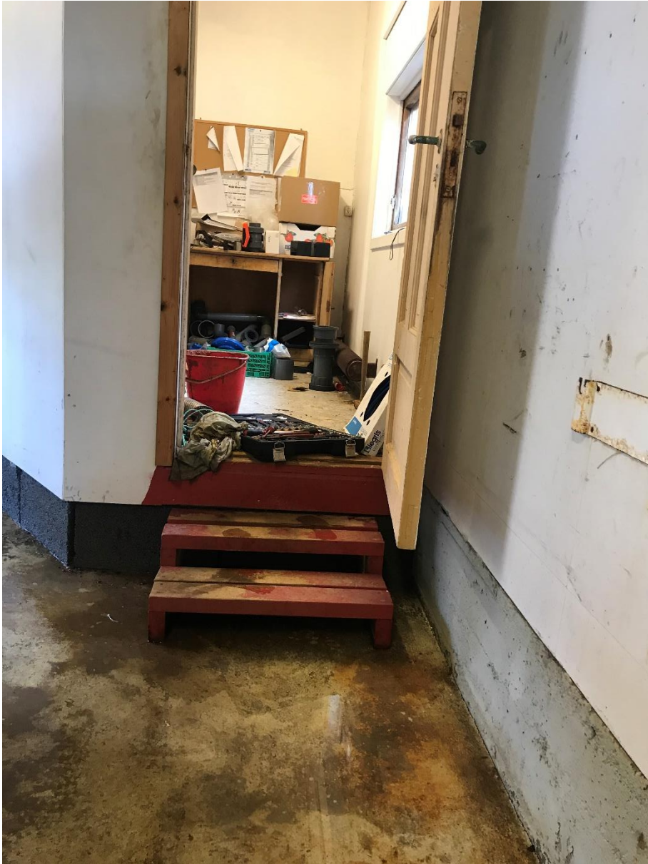
Figur 10: Lager. Dette rommet skal demonteres/rives før installasjon av nytt prosessanlegg. Gulvnivå vil bli på samme nivå som resten av bygget.
