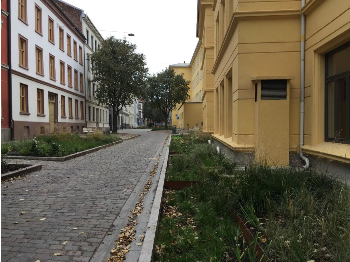
Figur 6-5: Eksempel på regnbed i etablert gaterom. Takvann og gatevann ledes til regnbedene. Regnbedene har metallkasser ved innløpene for oppsamling av slam og avfall.
