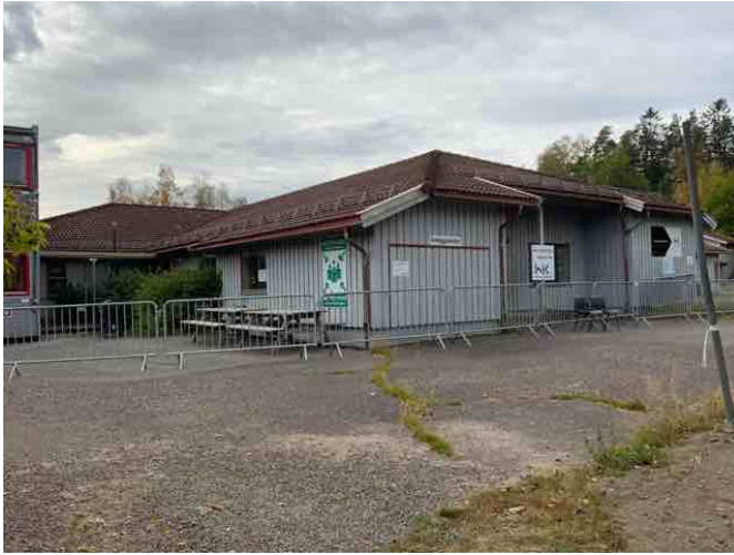
Bildet viser hovedbygget.
