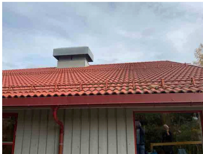
Taktekkingen på en side på deler av bygget har tekkning fra rundt 2014 og vurderes å ha grei tilstand. Dette gjelder grendehuset.
