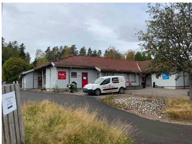
Bildet viser hovedbygget fra 1988.
