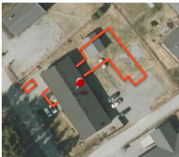
Figur: Oversiktsbilde som viser eksisterende bygg og nybygg
