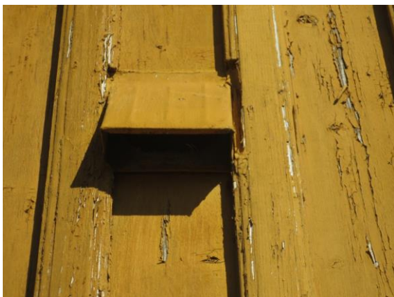
Beslag over ventil i vegg, alle ventiler er plassert i fasadens vestre del.
