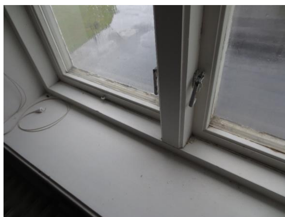
Eksempel på koblet vindu sett innenfra.
