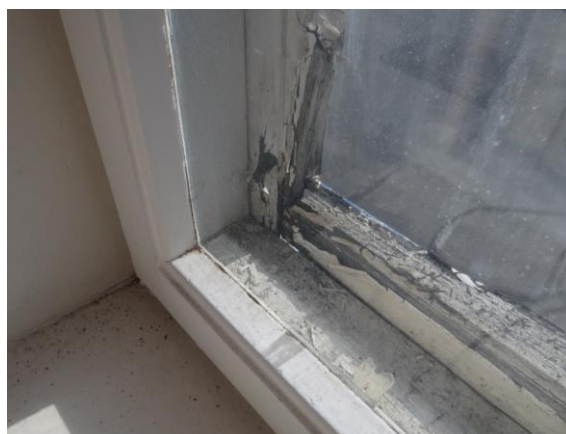
Lokale råteskader, glippe og løse glass i ytre ramme. Varevindueene er generelt i brukbar stand.
