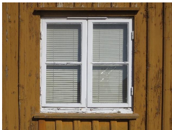
Eksempel på koblet vindu i relativt god stand. Krever vedlikehold/standardbehandling.
