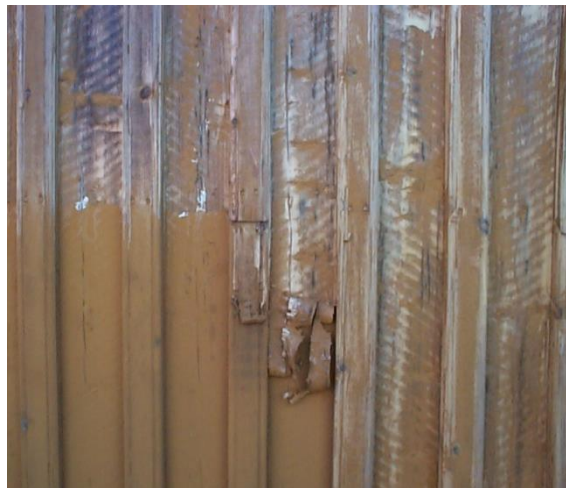
Malingsfjerning 2004, med full nedskraping.
