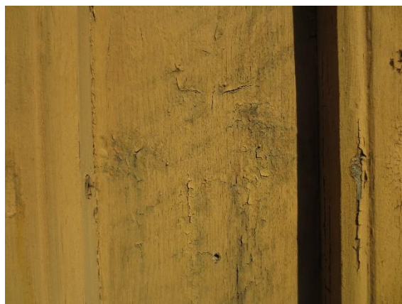
Det er lite svertesopp på sørveggen, men enkelte bord har merkbar svertesopp. Denne må fjernes.
