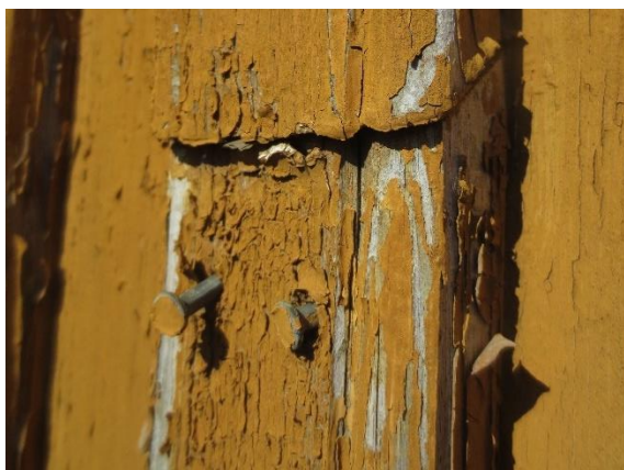
En del spiker er på vei ut, og noen lekter glipper. Behov for en del respikring.
