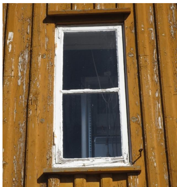
Typisk ettfags vindu over hver av de ytre dørfeltene. Konstruksjon lik øvrige vinduer, med enkle profiler og hjørnejern.
