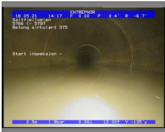
Foto: 6509_5766_5797_18052021_141739.JPG 0,5m, Start inspeksjon -
