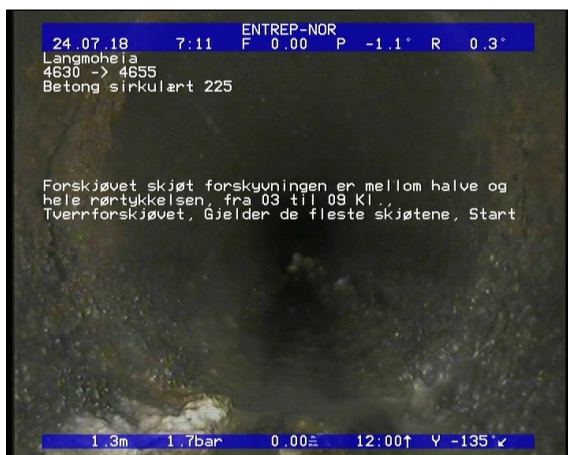
Foto: Forskjøvet skjøt forskyvningen er mellom halve og hele rørtykkelsen, fra 03 til 09 Kl., Tverrfø.JPG 1,33m, Forskjøvet skjøt forskyvningen er mellom halve og hele rørtykkelsen, fra 03 til 09 Kl., Tverrforskjøvet, Gjelder de fleste skjøtene, Start
