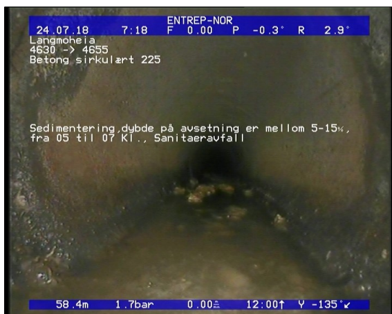
Foto: Sedimentering,dybde på avsetning er mellom 5-15, fra 05 til 07 Kl., Sanitaeravfall_07210358,41.JPG 58,41m, Sedimentering,dybde på avsetning er mellom 5-15%, fra 05 til 07 Kl., Sanitaeravfall
