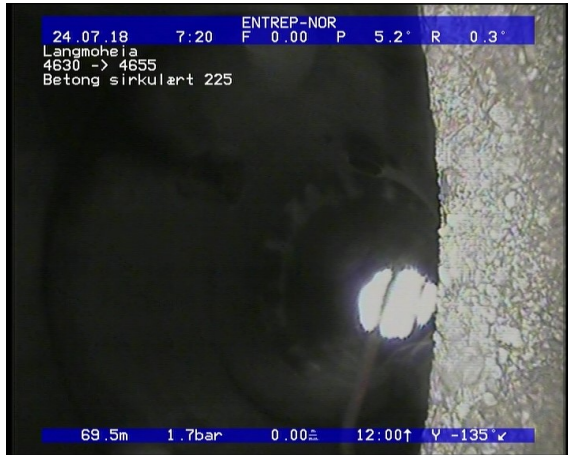
Foto: Inspeksjon fullført - _07232169,52_IF.JPG 69,52m, Inspeksjon fullført -
