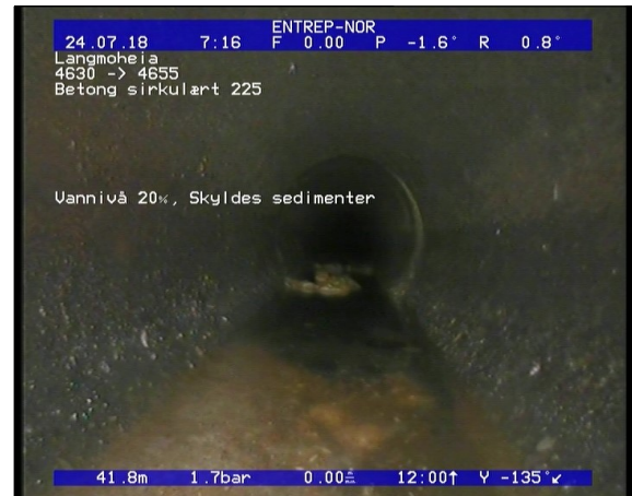
Foto: Vannivå 20, Skyldes sedimenter_07190241,87_VN.JPG 41,87m, Vannivå 20%, Skyldes sedimenter
